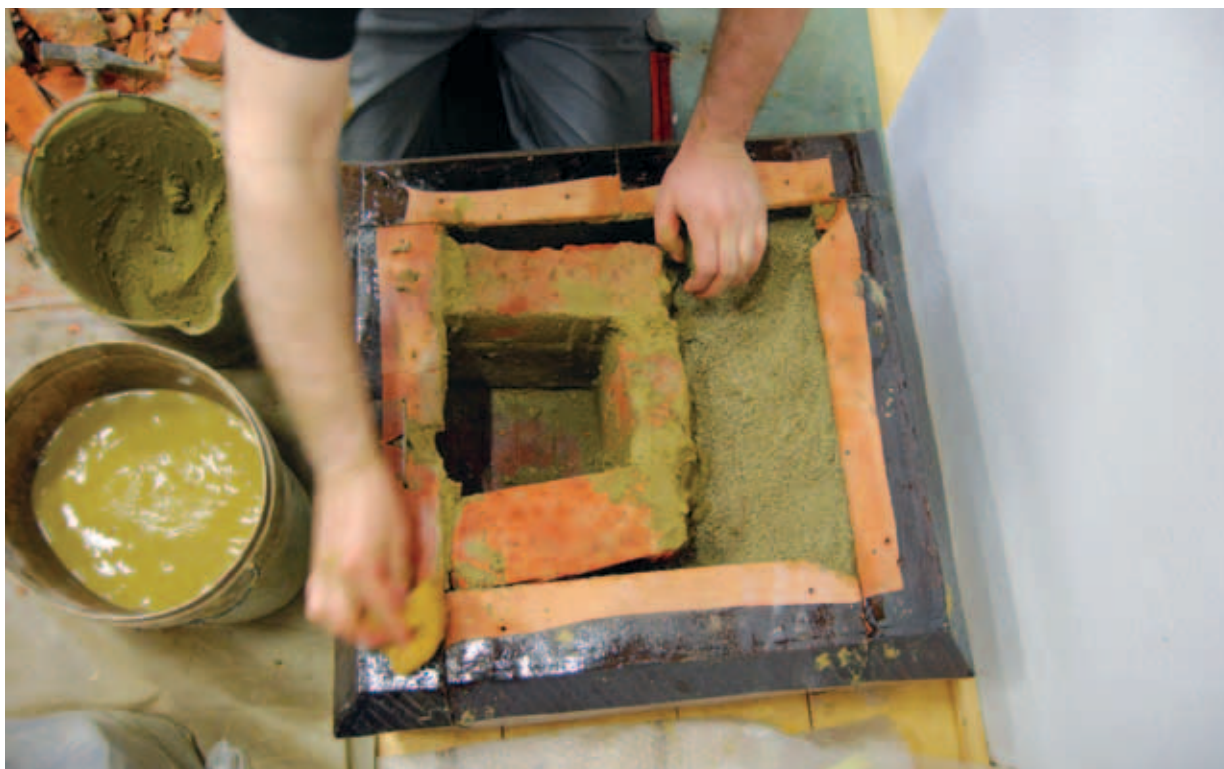
17. Smeđa peč, postupak ponovne montaže – zidanje temeljnog dijela (fototeka HRZ-a) The brown stove, reassembly – construction of the base (photographic archive of the HRZ)
