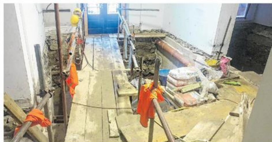
Prizemlje tijekom radova sanacije temelja
