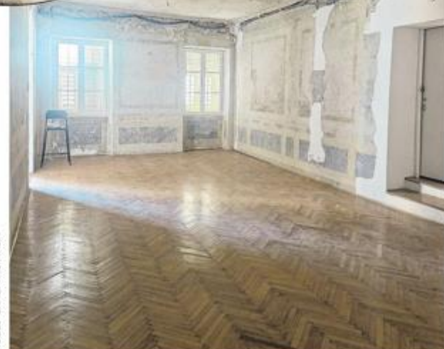
Pogled na prostoriju nakon saniranja stropa
