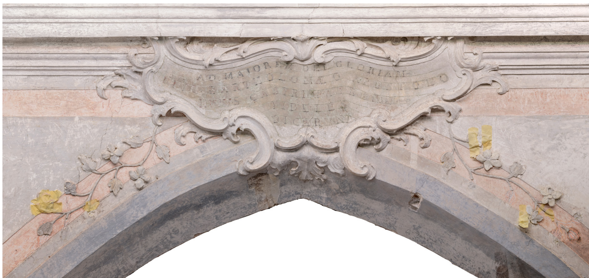
Roč, župna crkva sv. Bartola. Tjeme trijumfalnoga luka. Stanje nakon završetka čišćenja naknadnih naliča. Ortofotografija: Lj. Gamulin, 2025.
