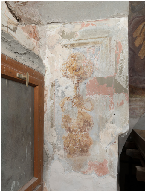
Varaždin, bivša ljekarna franjevačkog samostana. Istočna strana prozorske niše na sjevernom zidu. Stanje prije uklanjanja naknadnih slojeva naliča. Snimka: M. Jelenčić, 2025.
