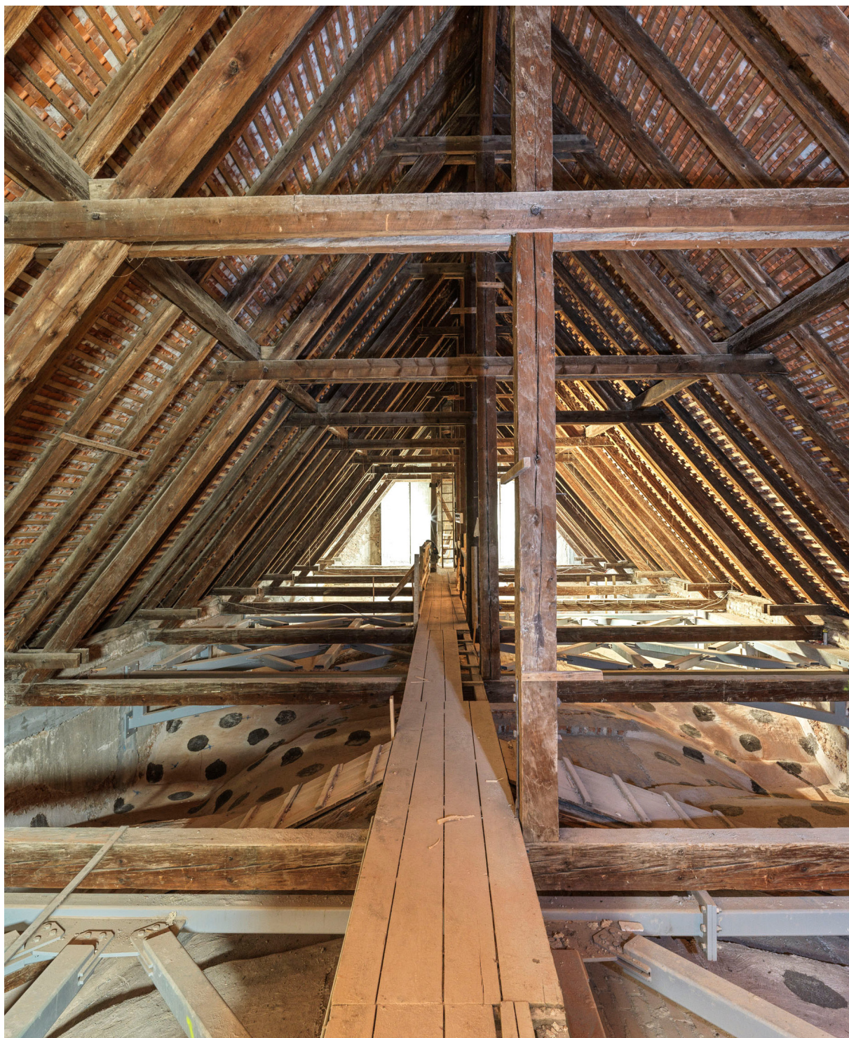
Zagreb, Akademska crkva sv. Katarine Aleksandrijske. Krovište nakon provedenih radova konstruktivne obnove. Snimka: Lj. Gamulin, 2025.
