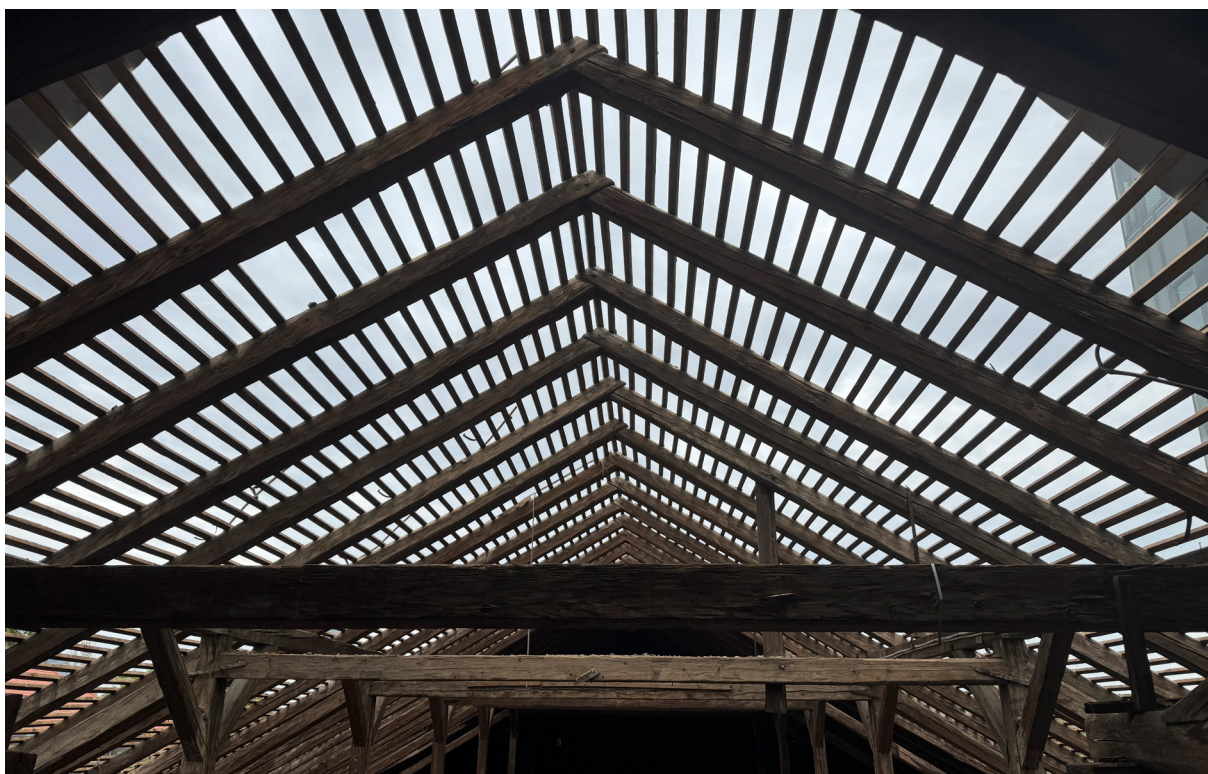
Zagreb, bivša Tvornica duhana u Zagrebu. Demontaža postojećeg krovišta. Snimka: B. Mostarčić, 2025.
