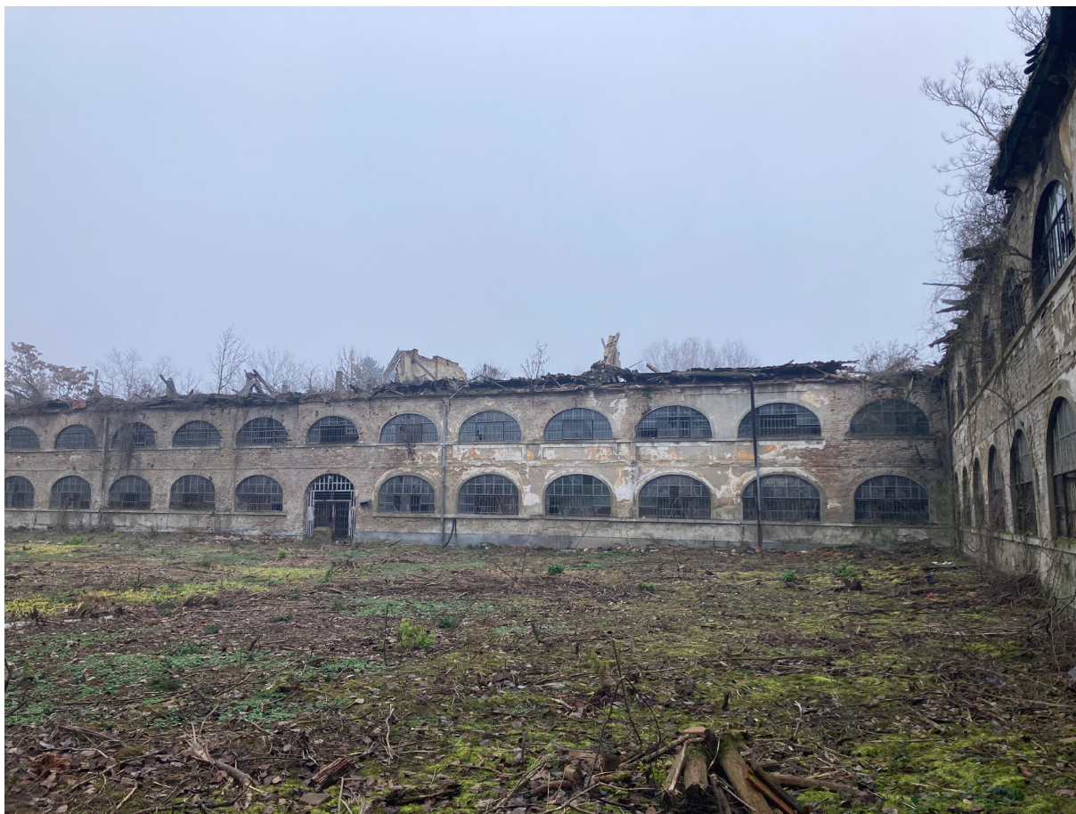
Stara Gradiška, tvrđava Stara Gradiška. Istočno krilo pješačke vojarne. Stanje nakon uklanjanja dijela krovišta i dimnjaka. Snimka: M. Sladović, 2025.
