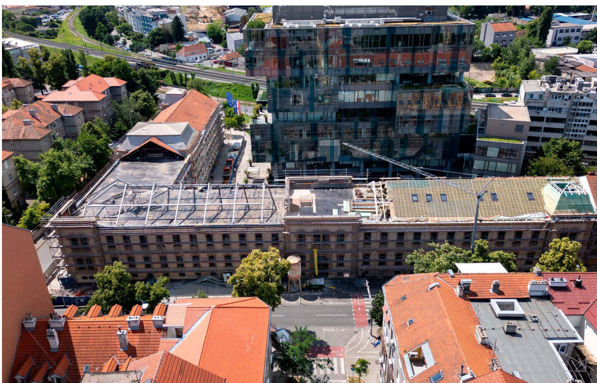
Zagreb, bivša Tvornica duhana u Zagrebu. Zračna snimka rekonstrukcije krovšta zgrade – pogled sa sjevera. Snimka: I. Čamber, 2025.
