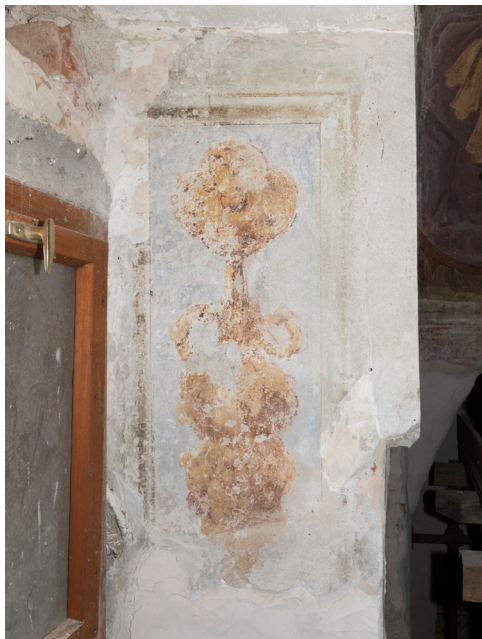
Varaždin, bivša ljekarna franjevačkog samostana. Istočna strana prozorske niše na sjevernom zidu. Stanje nakon uklanjanja naknadnih slojeva naliča. Snimka: K. Gavrilica, 2025.
