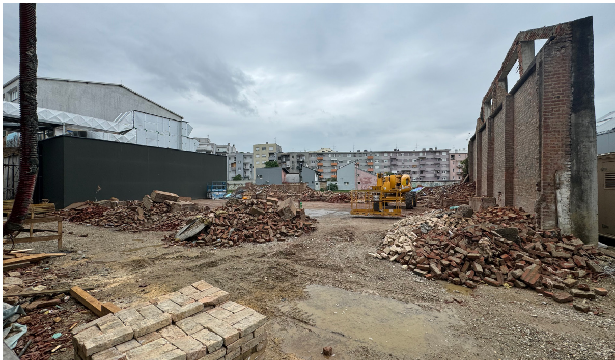
Zagreb, HNK 2, u sklopu kompleksa čuvaonica i radionica. Rušenje postojeće građevine. Snimka: B. Mostarčić, 2025.
