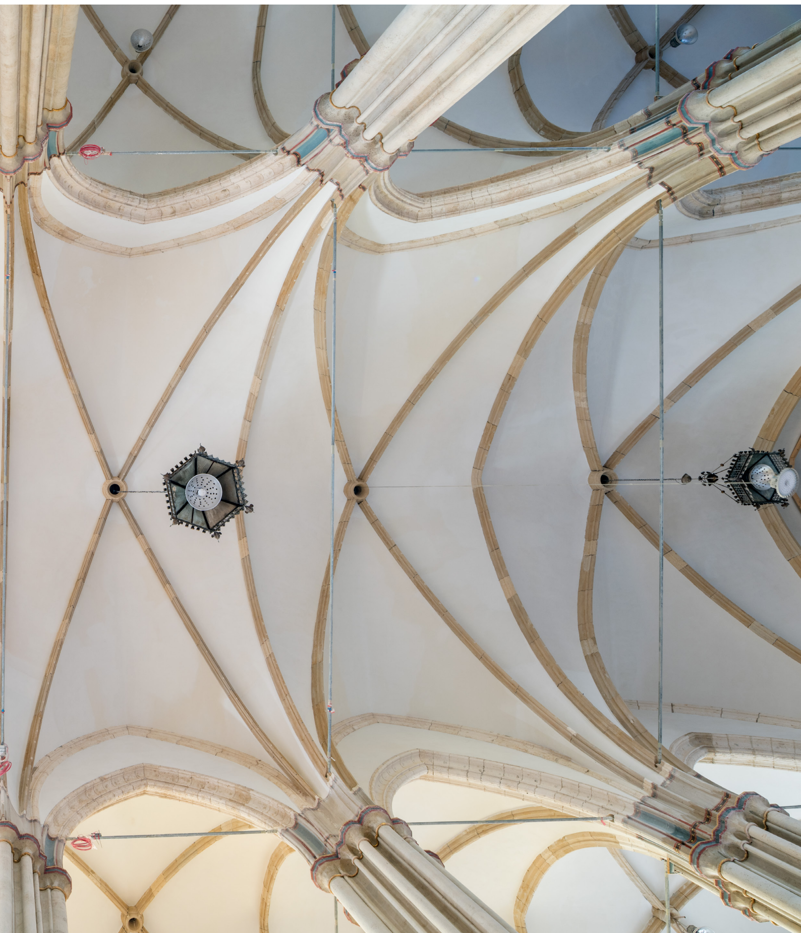
Zagreb, katedrala Uznesenja Blažene Djevice Marije i sv. Stjepana i Ladislava. Svod glavnog broda nakon radova statičke sanacije i uklanjanja skele. Snimka: K. Gavrilica, 2025.
