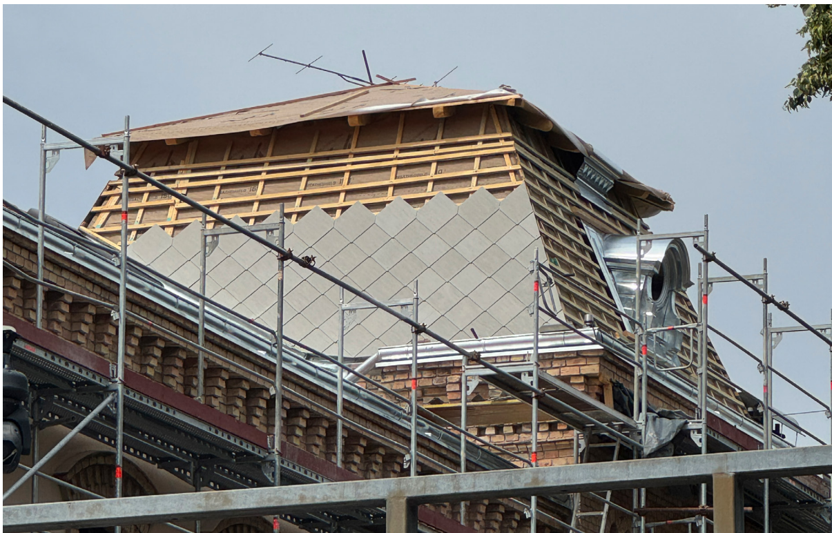
Zagreb, bivša Tvornica duhana u Zagrebu. Izrada krovšta velike kupole nad stubišnim rizalitom. Snimka: B. Mostarčić, 2025.
