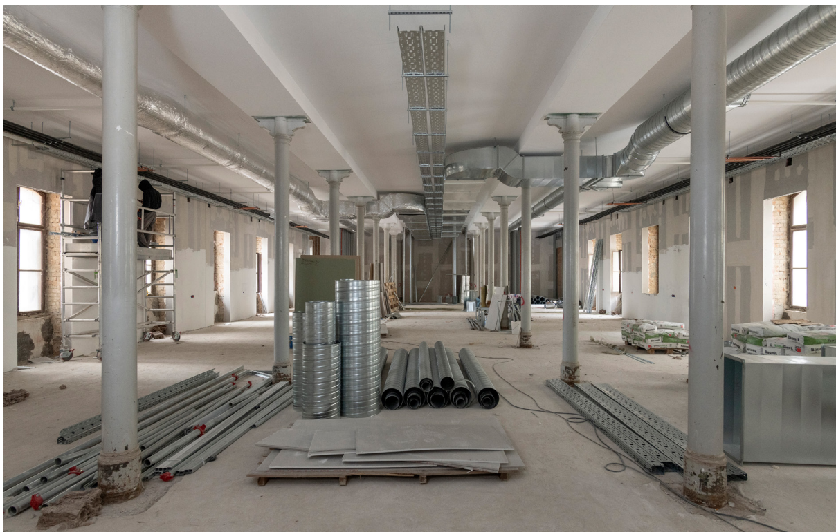
Zagreb, bivša Tvornica duhana u Zagrebu, postavljanje instalacija u radionici. Zračna snimka rekonstrukcije krovišta zgrade – pogled sa sjevera. Snimka: I. Marinković, 2025.
