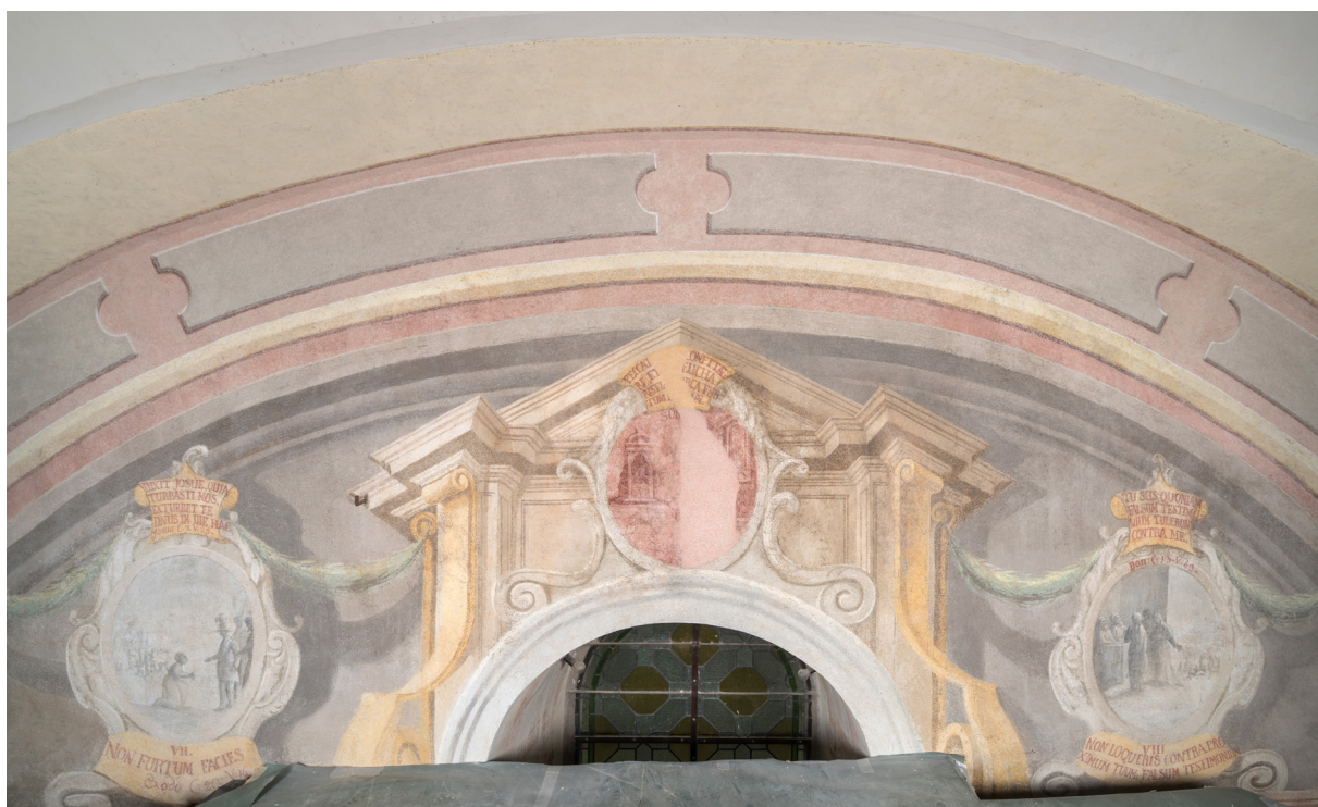
Jastrebarsko, crkva sv. Nikole. Luneta zapadnog zida pjevališta. Stanje nakon radova. Snimka: K. Gavrilica, 2025.
