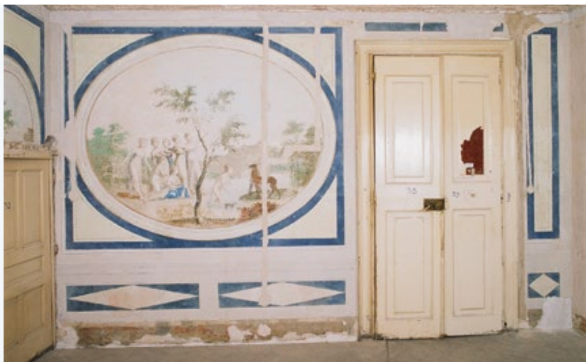
Slika 7. i 8. Rijeka, Upravna zgrada šećerane, zidne slike na istočnom zidu prostorije 22, prije i nakon čišćenja, 2009.-2010. (snimila Natalija Vasić) Slika 9. Rijeka, Upravna zgrada šećerane, čišćenje zidnih slika u prostoriji 22, 2009. (snimio Toni Šaina)
