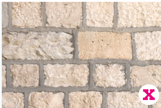
Nepropisno izvedena sljubnica: neadekvatni materijal i obrada (V. Marinković)
