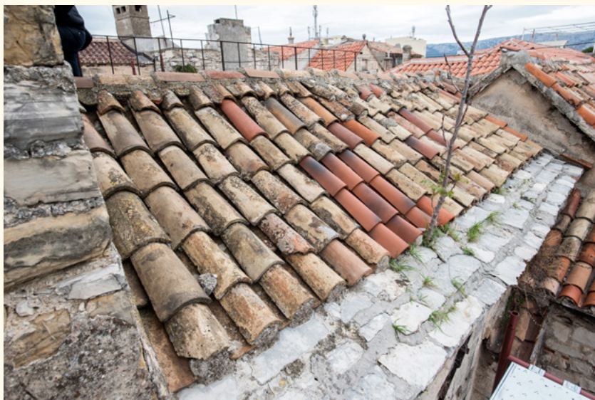
Detalj krova na kojemu su vidljivi ostaci starog kamenog pokrova i novih kupa kanalice (N. Vasić)
