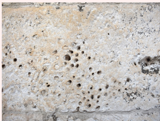
Primjer propadanja kamena zbog djelovanja atmosferilija (V. Marinković)
