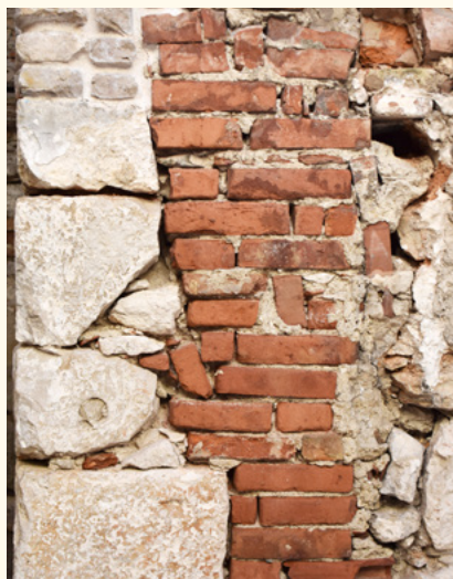
Detalj zida zidanog opekom i kamenom (V. Marinković)
