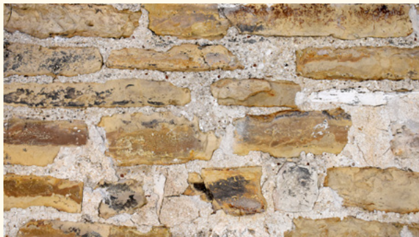
Detalj zida izgrađenog od sedimentnog kamena - fliša (V. Marinković)
