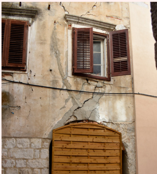
Statičko oštećenje na kući u Bulićevoj ulici br. 6., ovakva struktura je iznimno osjetljiva na potres (V. Marinković)
