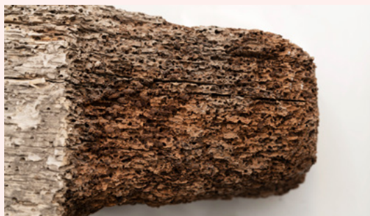
Primjer propadanja drvene grede međukatne konstrukcije (P. Gamulin)
