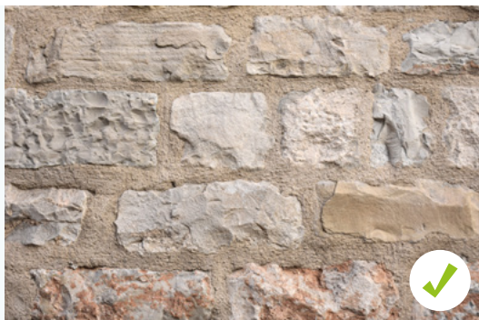
Propisno izvedena sljubnica vapnenim mortom (V. Marinković)
