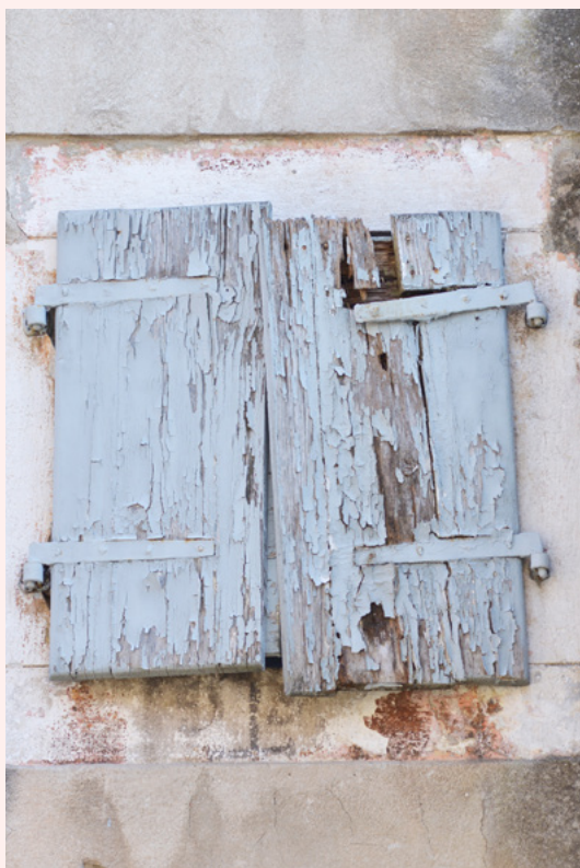
Unmaintained carpentry (J. Kliska)
