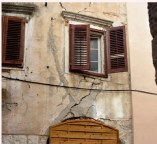
Statičko oštećenje na kući u Buličevoj ulici br. 6. Ovakva struktura je iznimno osjetljiva na potres (V. Marinković)
