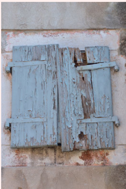
Unmaintained carpentry (J. Kliska)
