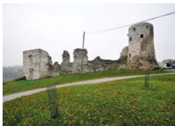
Slika 26. Pogled na sjeverni zid nakon sanacije i prije rekonstrukcije, 2012. godine (fototeka HRZ-a, snimila N. Vasić).
