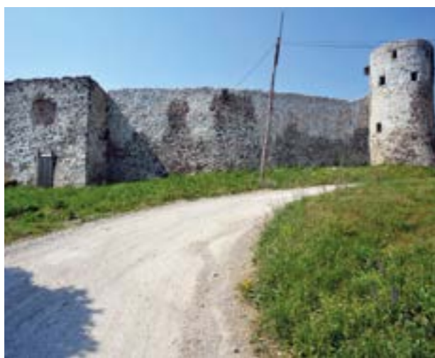
Slika 27. Pogled na sjeverni zid nakon rekonstrukcije, 2013. godine (fototeka HRZ-a, snimio J. Kliska).
