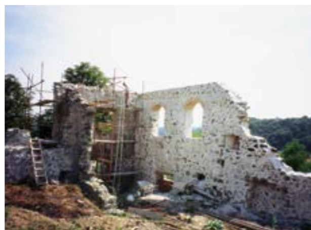
Slika 28. Četverokutna sjeveroistočna kula tijekom radova sanacije i rekonstrukcije otvora, 2006. godine (fototeka HRZ-a, snimio D. Čikara).
