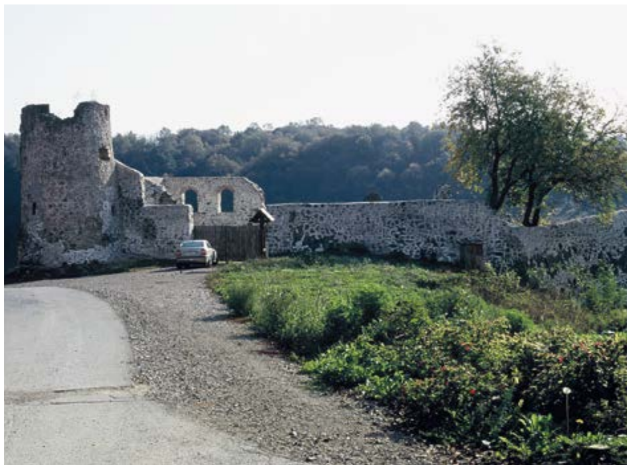
Slika 34. Pogled na sjeverni i zapadni zid nakon rekonstrukcije njihovih visina, 2008. godine (fototeka HRZ-a, snimila N. Vasić). Fig. 34. View of northern and western walls after reconstruction of their original height, 2008 (CCI photo archives, photograph by N. Vasić).
