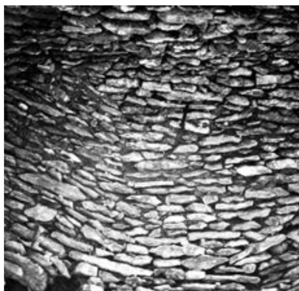
Slika 22. Kameni svod u sjevernoj kružnoj kuli snimljen 1984. godine. Svod je srušen između 1991. i 1998. godine (fototeka HRZ-a, snimio D. Miletić).
