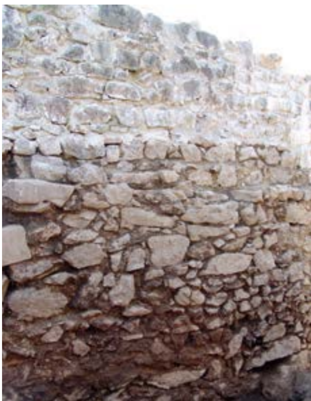
Slika 40. Struktura zidova u feudalnoj fazi Staroga grada Barilovića, jugozapadni obrambeni zid, pogled sa sjeveroistoka. Gornji dio zida konzerviran je 2009. godine (Arhiv HRZ-a, snimila A. Azinović Bebek).
