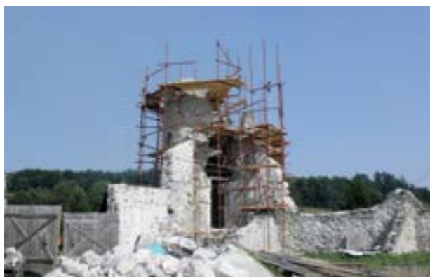
Slika 25. Sjeverna kula, nakon sanacije zidova i tijekom radova rekonstrukcije i dozidavanja, 2009. godine (fototeka HRZ-a, snimila N. Vasić).
