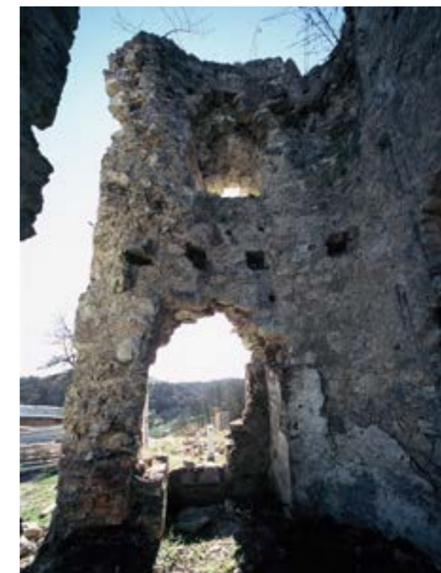
Slika 24. Sjeverna kula, unutrašnjost, tijekom radova sanacije. Na zidovima su vidljivi ležajevi drvenih greda, 2008. godine (fototeka HRZ-a, snimila N. Vasić).
