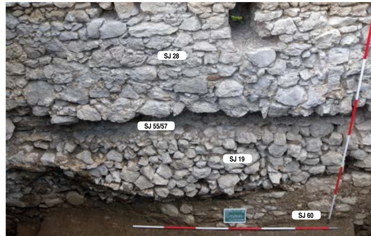
Slika 44. Jugozapadni obrambeni zid, SJ 60 – najdonji, žbukani dio, feudalna faza grada, SJ 19 – srednji dio, popravljane krajem 16. st., utor za katnu konstrukciju SJ 55/57 te SJ 28 – zid iznad katne konstrukcije iz vremena Vojne krajine, gornji dio tog zida konzerviran je 2010. godine (Arhiv HRZ, snimio A. Janeš).
