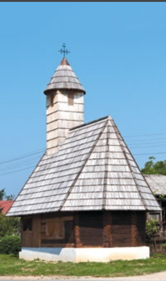
Kapela nakon građevinskih radova. Snimio: Lj. Gamulin, 2013. Fototeka HRZ-a.
