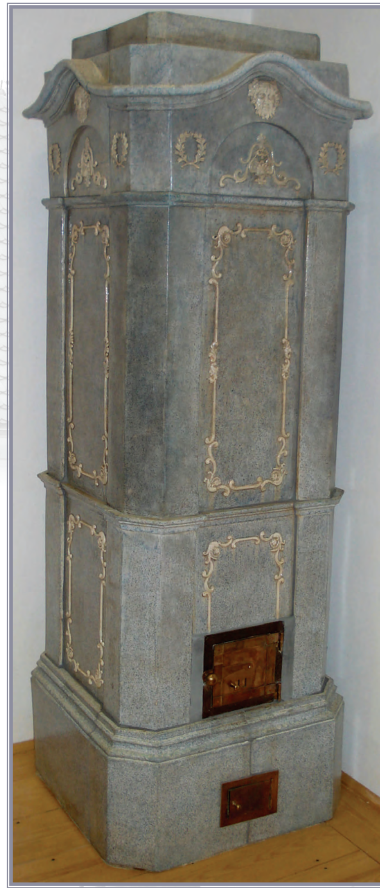
Slike gore: Na ovoj je peći bilo i nekoliko slojeva popravaka bojom i lakovima koji su se pomoću visoke temperature kod korištenja spojili s glazurom. Ti dijelovi postali su bitno tamniji od originala. Vezivni materijal je požutio i djelomice izgorio, a ostatak je sa površine odstranjivan u procesu restauriranja.
