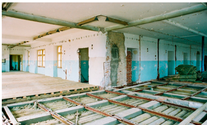
Sanacija međukatne konstrukcije (arhiva HRZ-a, 1998.)
