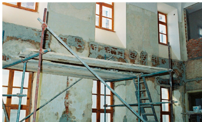
Građevinski radovi u svečanoj dvorani (arhiva HRZ-a, 1999.)
