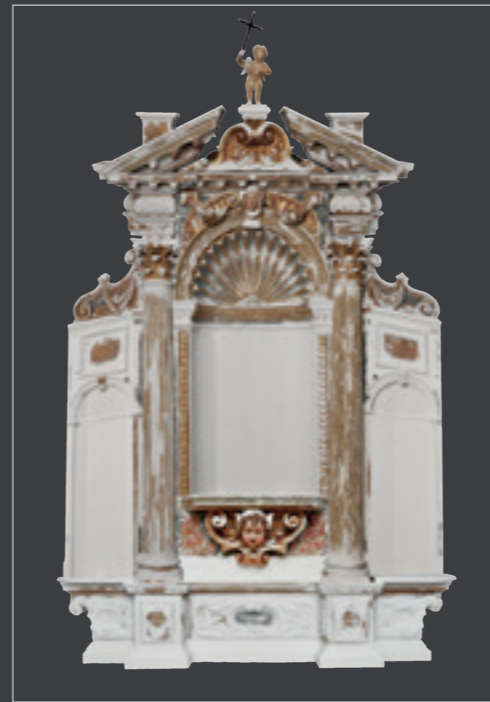
Oltar Pohođenja nakon rekonstrukcije oštećenja u sloju podloge oslika i pozlate. Snimio: J. Škudar, 2015. Fototeka HRZ-a. Fotomontaža/obrada T. Rovičanec
