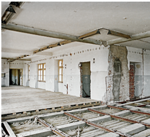
Radovi na sanaciji međukatne konstrukcije Construction improvement of the woodwork between the storeys
