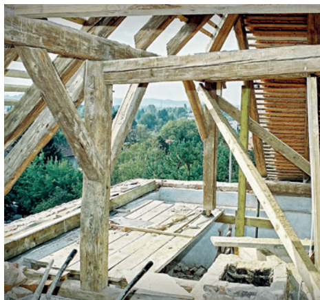
Konstruktivna sanacija dijela krovišta Construction improvement of a portion of the roof
