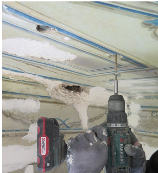
Bizovac, dvorac Norman, priprema za učvršćivanje tršćane građe stropa (snimka: D. Jurčić, 2022.)
