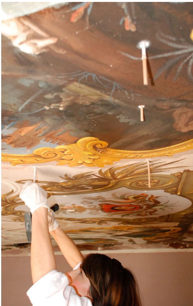
Split, Palača Bajamonti-Dešković, umetanje drvenih štapića (snimka: I. Jerković, 2010.)
