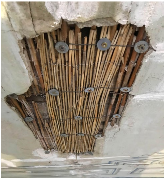
Bizovac, dvorac Norman, učvršćivanje tršćane građe stropa (snimka: D. Jurčić, 2022.)
