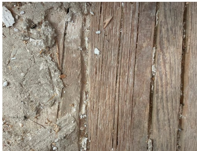
Rovinj, Muzej grada Rovinja, preširoke stropne letvice s premalim razmakom (snimka: B. Orbanić, 2025.)
