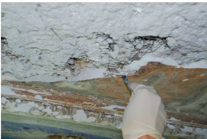
Consolidation of damaged edges of the painting (photo: A. Jazbec, 2012) Konsolidacija oštećenih rubova oslika (snimka: A. Jazbec, 2012.)
