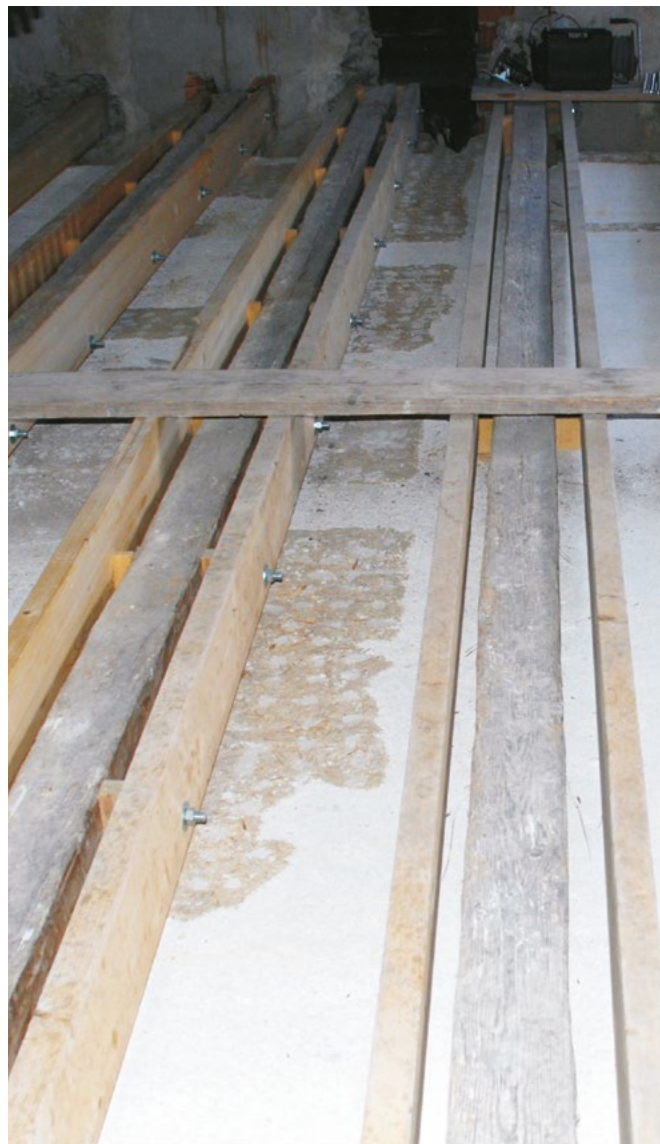
Upper side of the painted ceiling after restoration (photo: A. Jazbec, 2012) Gornja strana oslikanog stropa nakon restauracije (snimka: A. Jazbec, 2012.)
