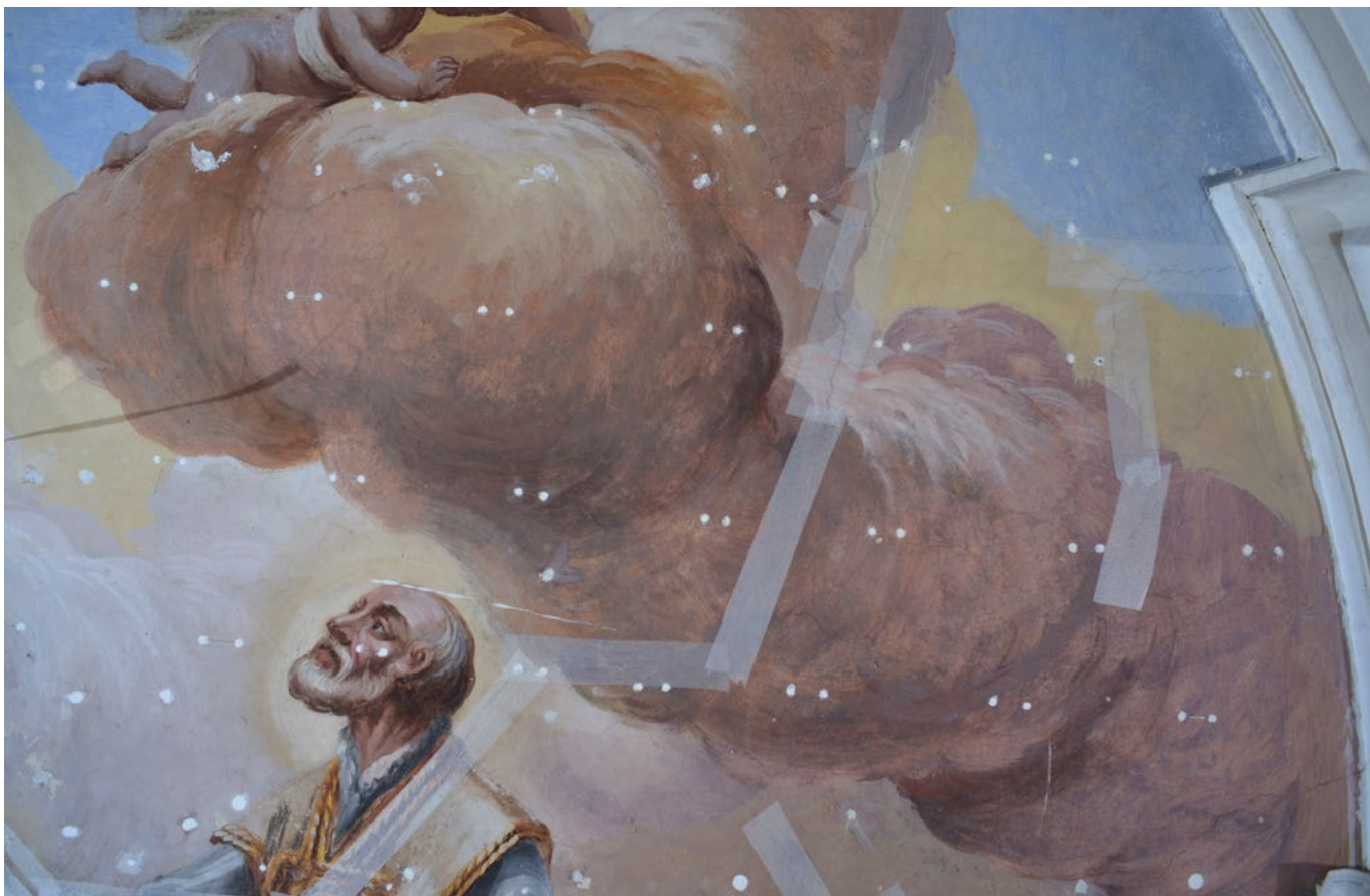
Buzet, crkva sv. Jurja, detalj oslika stropa nakon učvršćivanja PVC nitima (arhiva HRZ-a, snimka: J. Kliska, 2013.)
