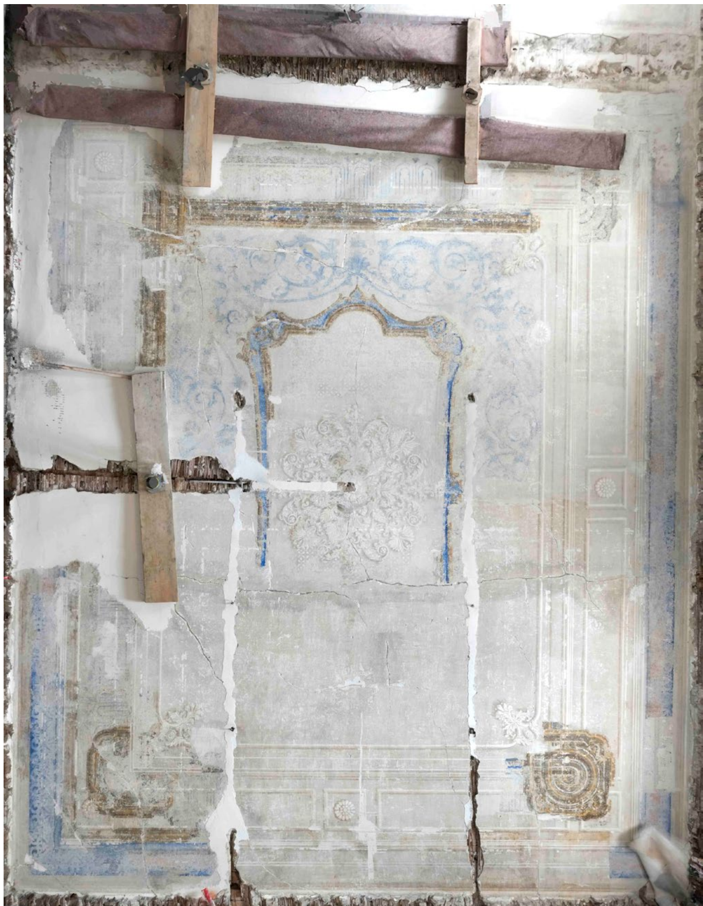
Zagreb, Palača Drašković, Opatička 18. Salon 8 – stanje stropa tijekom uklanjanja recentnih naliča i cementnih zakrpa (ortofoto snimka: Pro Elemento d.o.o., 2025.)
