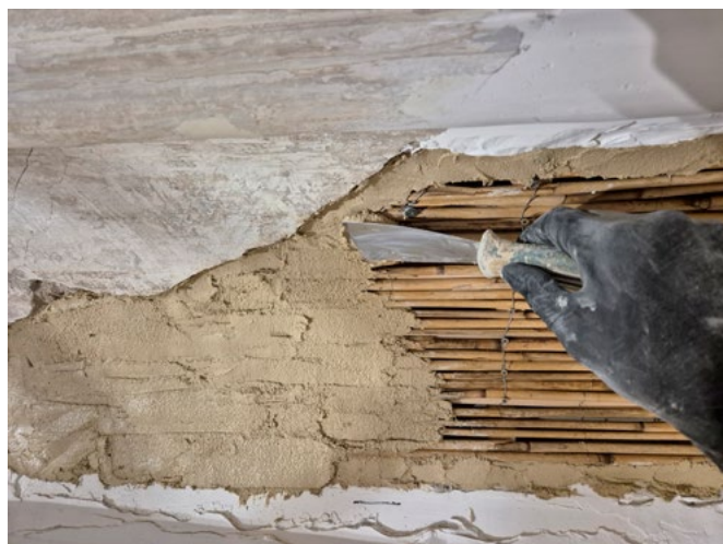
Zagreb, Hrvatski povijesni muzej, nanošenje nove vapnene žbuke na trščanu građu holkela (snimka: D. Matešan, 2025.)
