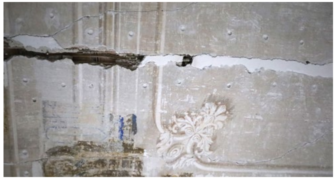
Zagreb, Palača Drašković, Opatička 18. Salon 8 – učvršćivanje odvojene tršćane građe za gredu ankeriranjem nehrđajućim vijcima s maticama i vlaknastom žbukom (snimka: A. Dumbović, 2025.)
