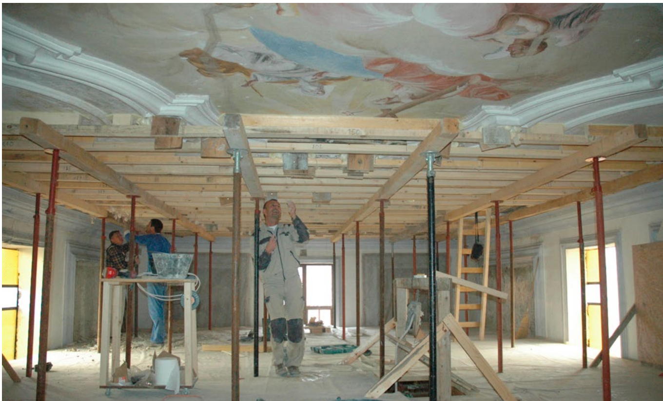
Buzet, crkva sv. Jurja, podupiranje stropa i konstruktivna sanacija žbuke i štukatura stropa (arhiva HRZ-a, snimka: T. Šaina, 2010.)
