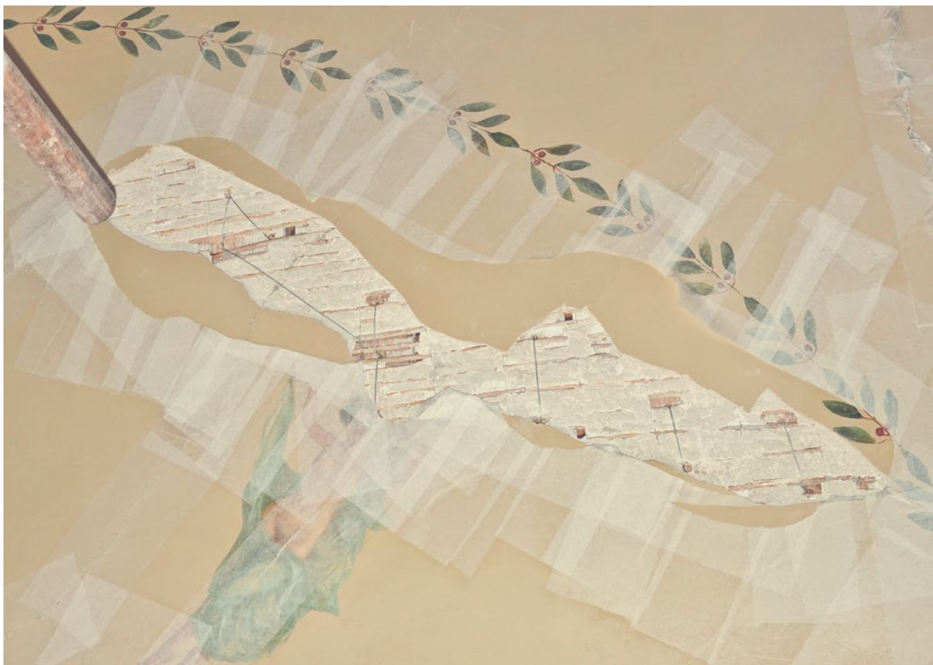
Zagreb, Palača bogoštovlja i nastave (Hrvatski institut za povijest), Pompejanska soba – tijekom konzervatorsko-restauratorskih radova; preventivna zaštita oštećenog dijela stropa (arhiva HRZ-a, snimka: A. Filip, 2022.)
