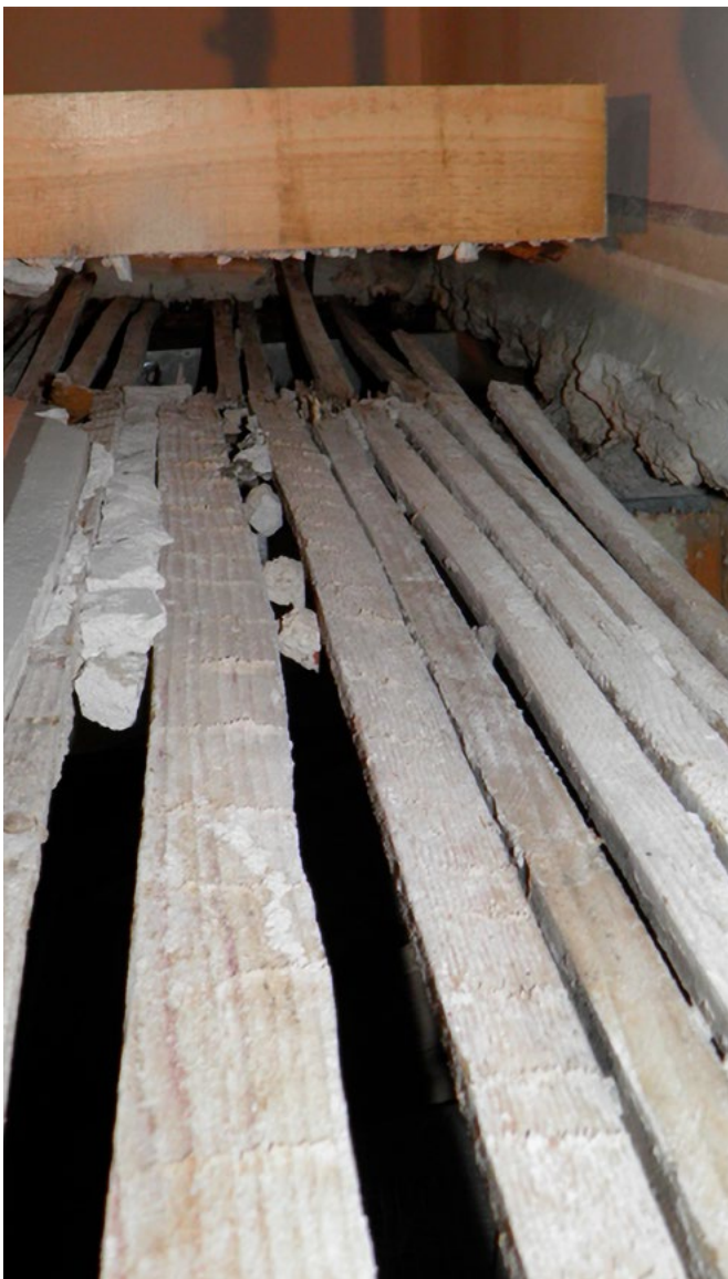
Labin, Teatrino, preširoko postavljene stropne letvice (snimka: S. Tomišić, 2019.)
