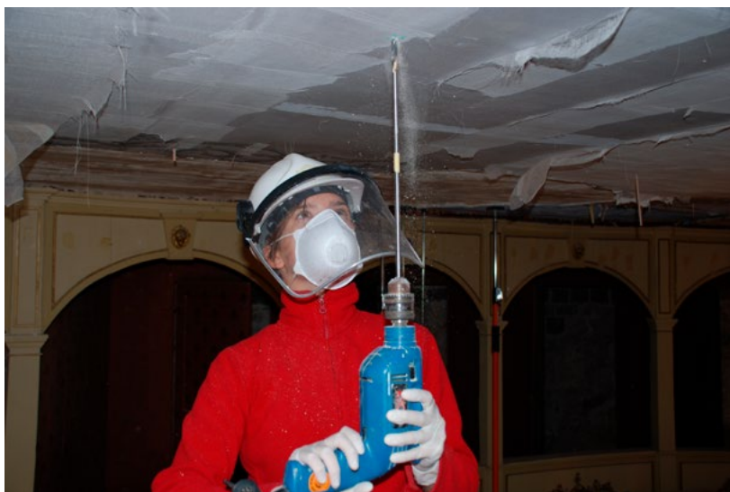
Hvar, Kazalište, priprema za umetanje drvenih štapića (snimka: A. Gluhan, 2010.)
