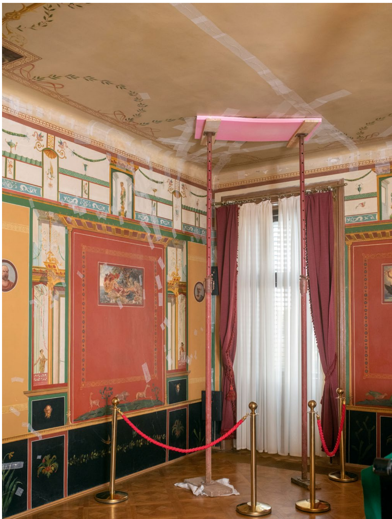
Zagreb, Palača bogoštovlja i nastave (Hrvatski institut za povijest), Pompejanska soba – preventivno podupiranje oštećenog stropa (arhiva HRZ-a, snimka: J. Kliska, 2020.)
