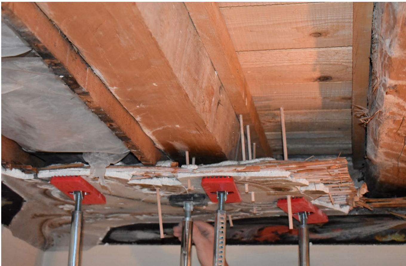
Split, Palača Bajamonti-Dešković, učvršćenje odvojenih dijelova stropa (snimka: A. Gluhan, 2018.)
