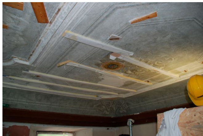
Protection of the ceiling from detachment using foam-covered slats fastened with screws through the plaster into the wooden structure (photo: A. Jazbec, 2012) Zaštita stropa od odvajanja pomoću letvica obloženih pjenom, pričvršćenih vijcima kroz žbuku u drvenu konstrukciju (snimka: A. Jazbec, 2012.)
