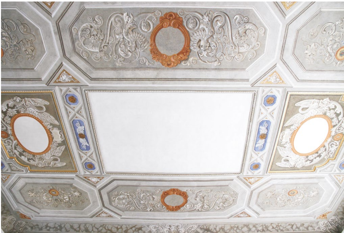
Painted ceiling after restoration (photo: A. Jazbec, 2012) Oslíkani strop nakon restauracije (snimka: A. Jazbec, 2012.)
