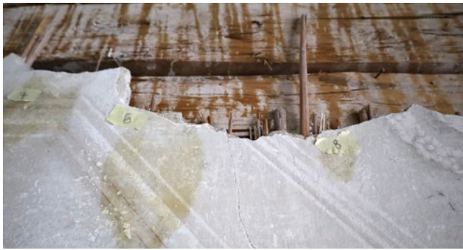
Zagreb, Palača Drašković, Opatička 18. Salon 9 – probe injektiranja žbuke (snimka: A. Dumbović, 2025.)
