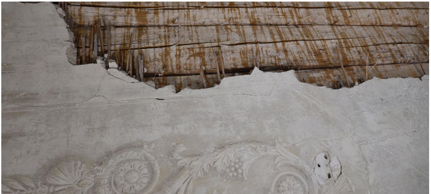
Zagreb, Palača Drašković, Opatička 18. Salon 9 – nedostatak tršćano-žbukane građe s oslikom na južnoj strani stropa (snimka: A. Dumbović, 2025.)
