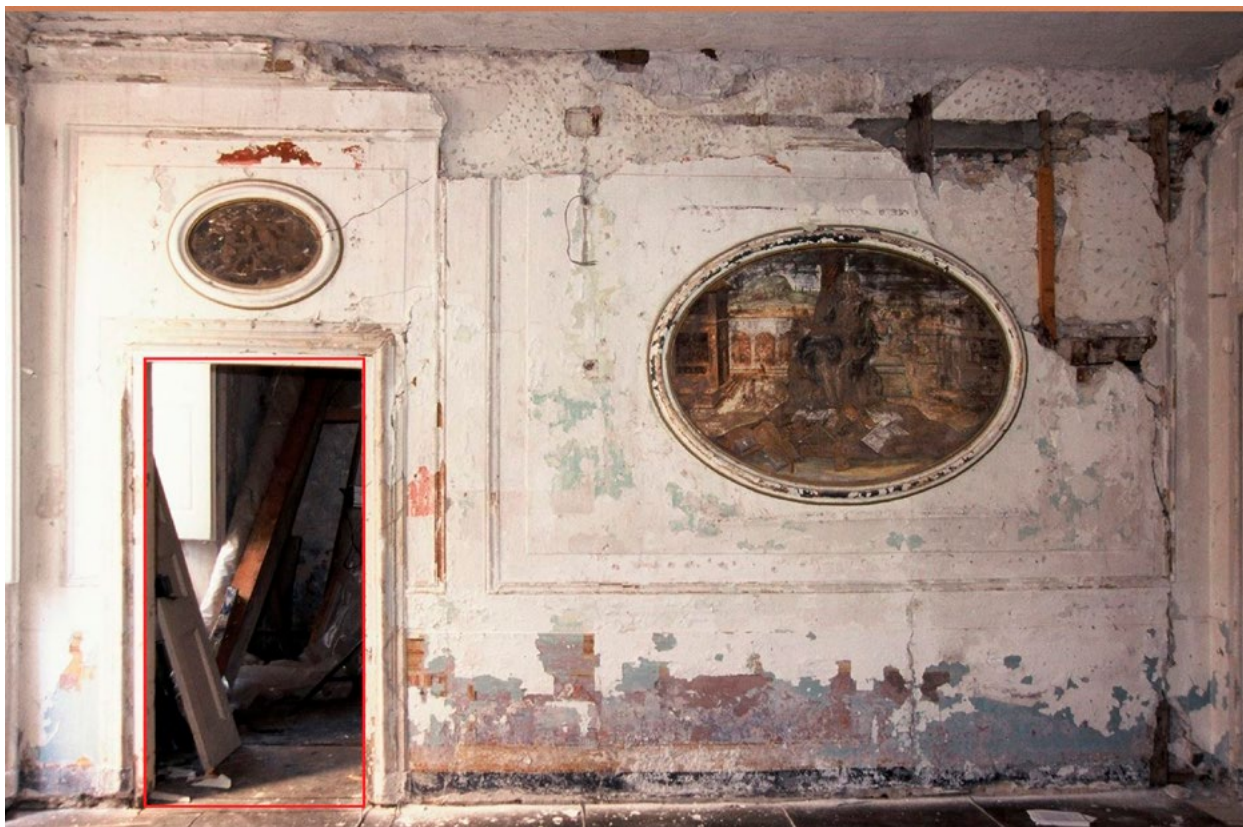
Palača Kerša (Festivalska palača) Dubrovnik, Salon S-I-5, pogled na sjeverni pregradni zid prije radova (arhiva HRZ-a, snimka: I.Srša, 2002.)
