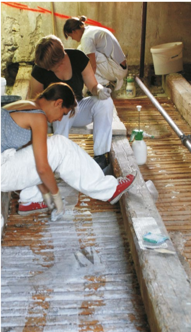
Consolidation of the upper side of the painted ceiling (photo: A. Jazbec, 2012) Učvrščivanje gornje strane oslikanog stropa (snimka: A. Jazbec, 2012.)
