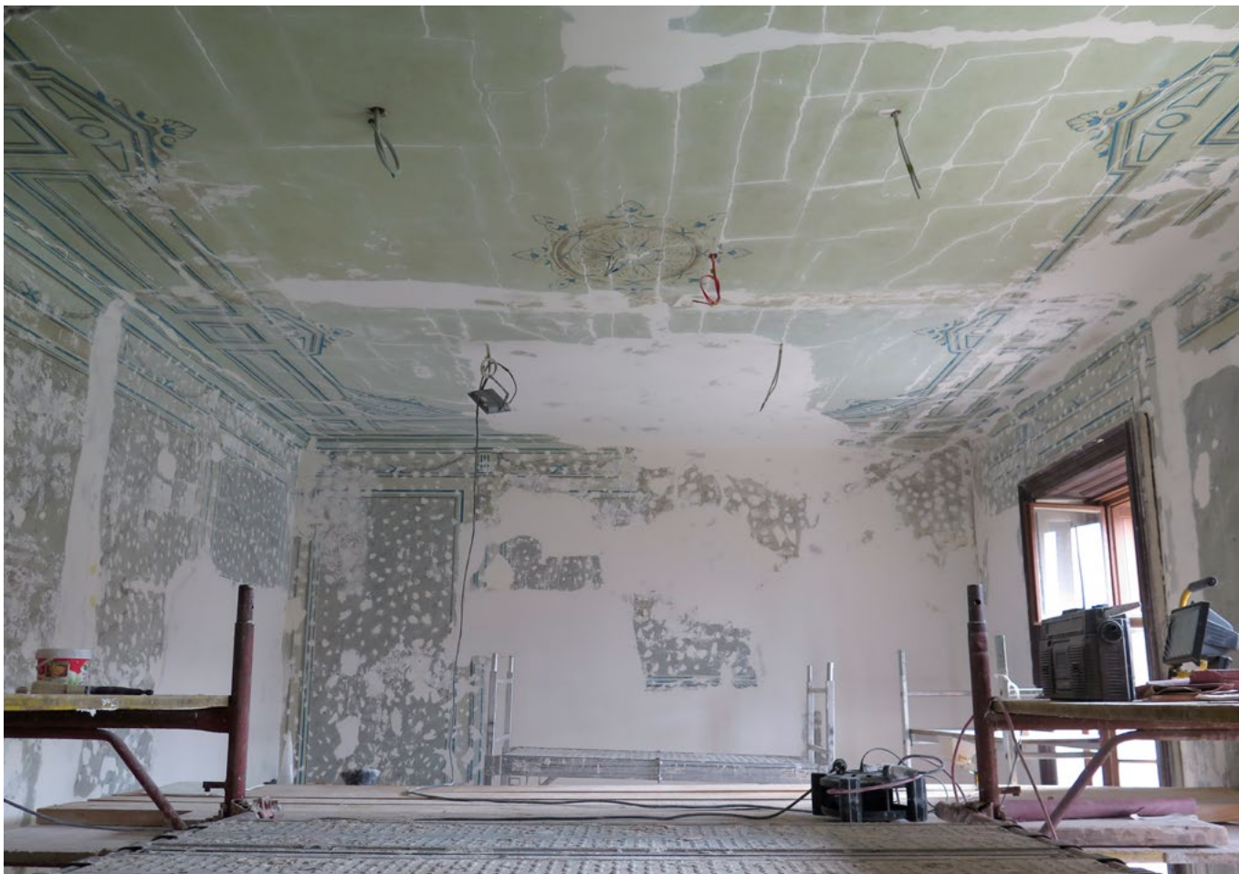
Bizovac, dvorac Norman, prostorija nakon reintegracije žbuknog sloja (snimka: M. Buljan, 2022.)
