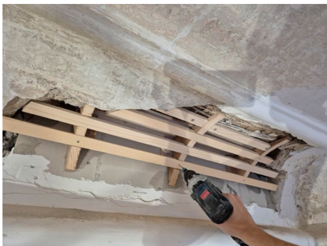
Zagreb, Hrvatski povijesni muzej, rekonstrukcija drvenog nosioca holkela (snimka: D. Matešan, 2025.)
