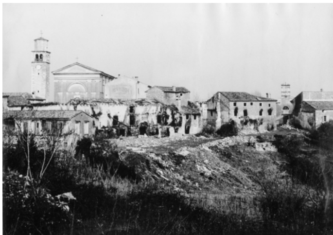
Vižinada, oštećenje kuće Grimani nakon snimanja filma Kelly's Heroes, fototeka Konz. odjela Rijeka, snimio: V. Malinarić, 1970.
