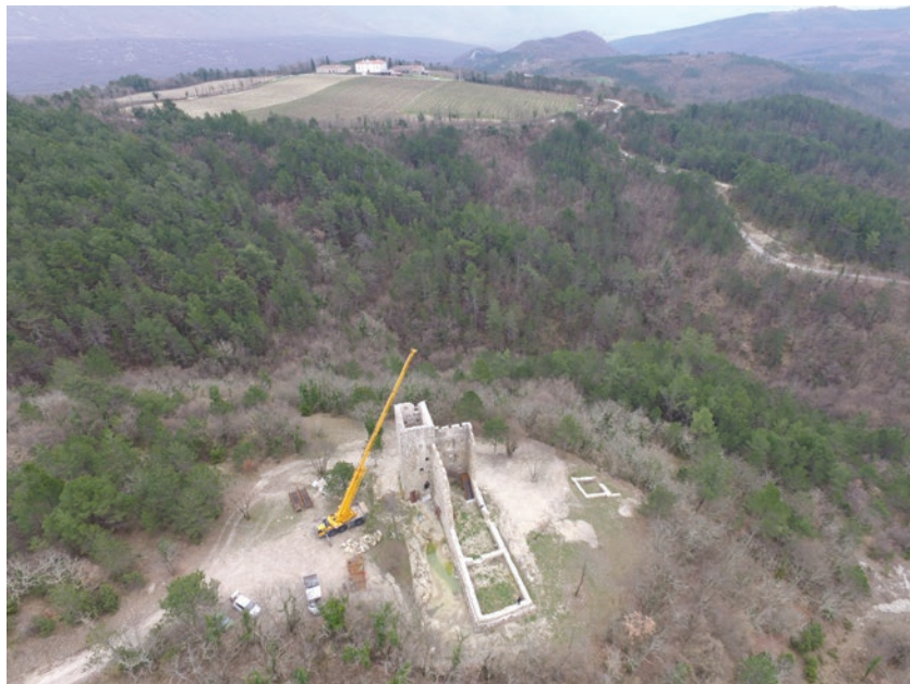
Pogled na Posert iz zraka tijekom radova
