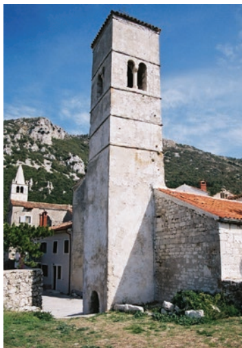
Plomin, istočna kula nakon obnove, 2015.
