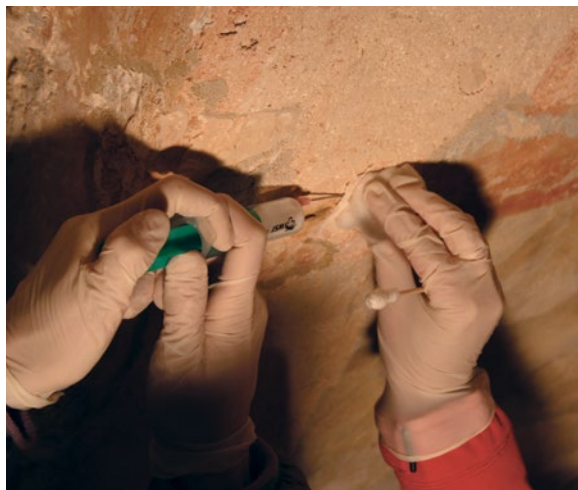
|| Consolidation of swollen plaster Konsolidacija podbuhle žbuke
