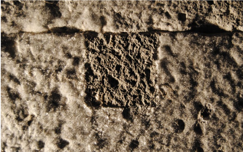
| Defined area (size: 5 cm 2 ) used for monitoring of new salt crystallizations in the Crypt of St. Maria im Kapitol in Cologne, Germany Ograničena površina (veličine 5 cm 2 ) za praćenje novonastalih kristalizacija soli u kripti crkve sv. Marije na Kapitolu u Kölnu, Njemačka
