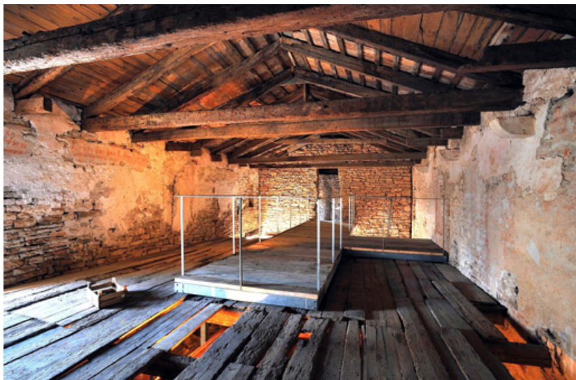
Bivša crkva sv. Stjepana, unutrašnjost nakon restauracije
