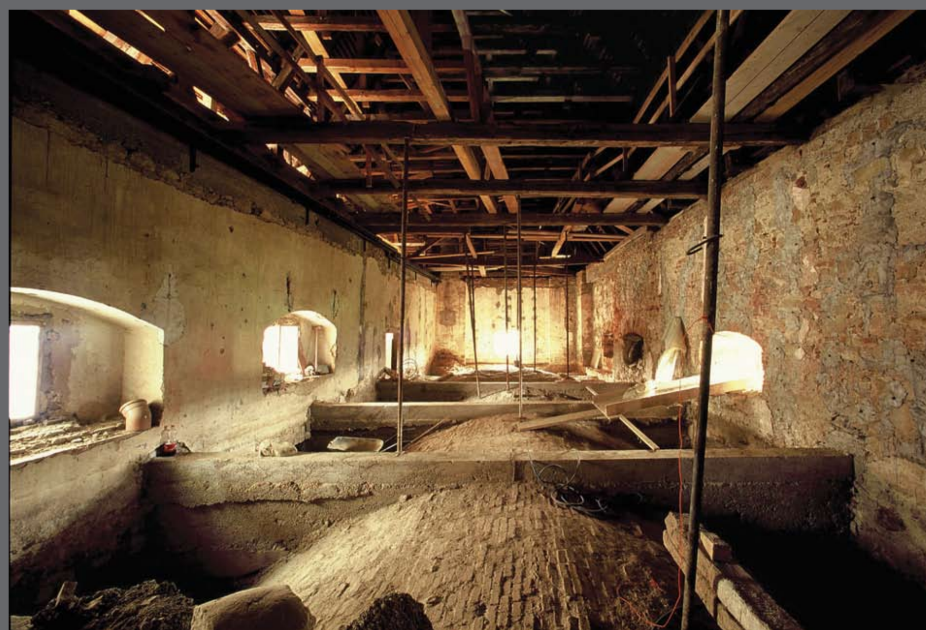
Sjeverno krilo, drugi kat, stanje prije radova.
