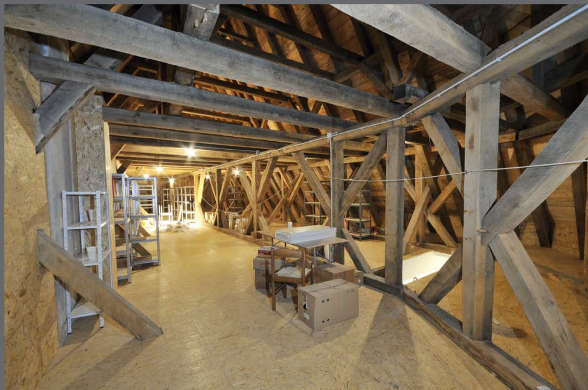
Depo u potkrovlju sjevernog krila.
