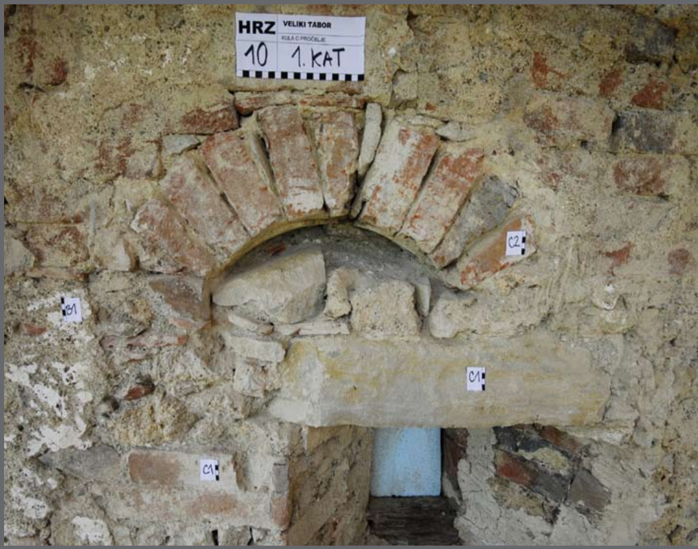
Pročelje kule, sondiranje otvora.
