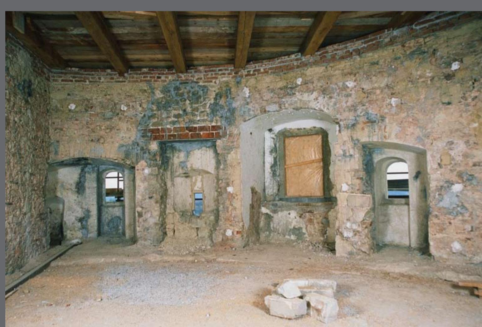
Drugi kat, južna prostorija, pogled na vanjski zid, nakon konz.-rest. radova, tijekom radova obnove.
