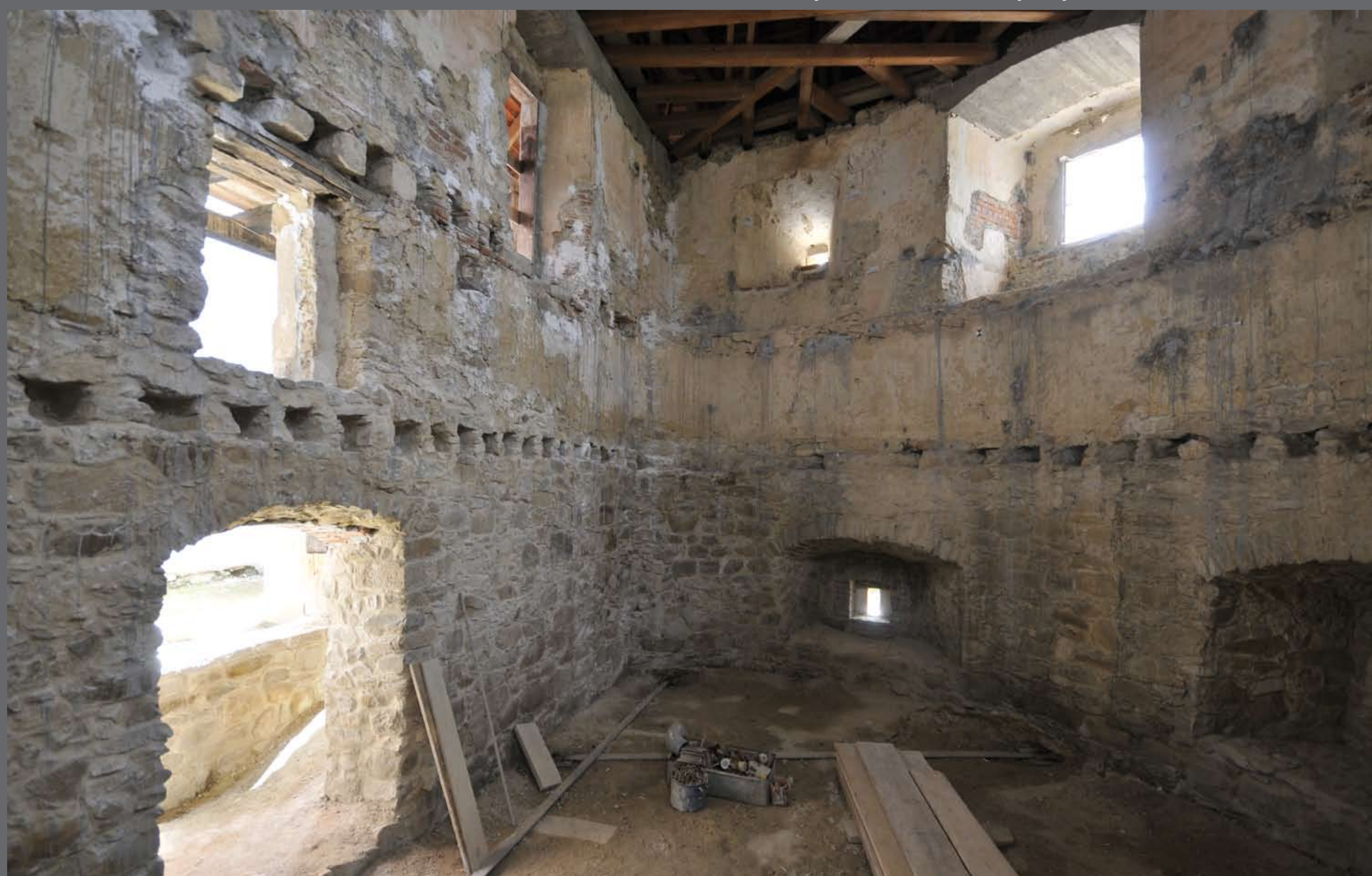
Unutrašnjost, nakon istraživanja i tijekom radova obnove.
