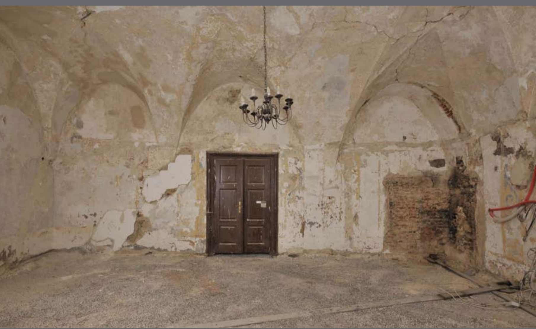
Prvi kat, sjeverna prostorija, južni zid tijekom uklanjanja naknadnih žbukanih i ličenih slojeva.
