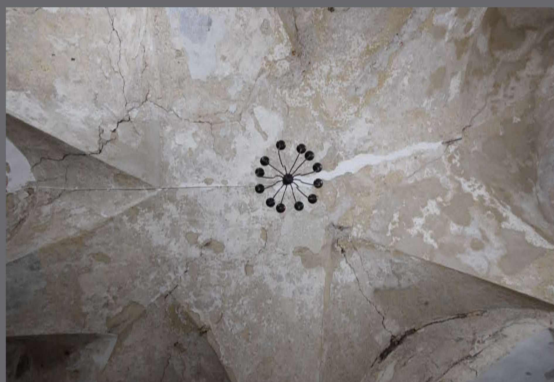
Prvi kat, sjeverna prostorija, svod nakon uklanjanja naknadnih žbukanih i ličenih slojeva.
