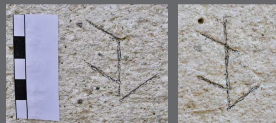
Klesarski znakovi na kamenim konzolama kule.
