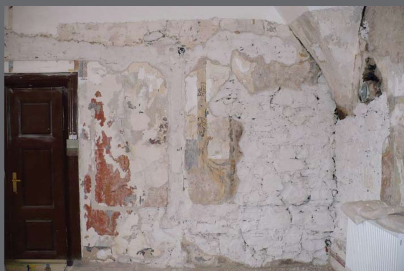
Sjeverno krilo, prvi kat, srednja prostorija, dio istočnog zida tijekom uklanjanja naknadnih žbukanih i ličenih slojeva.
