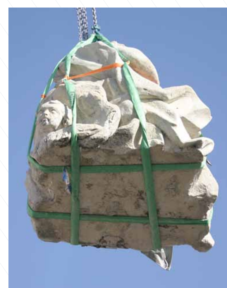
Demontaža oblaka kompozicije sv. Trojstva Dismantling of the cloud from the upper part of the monument
