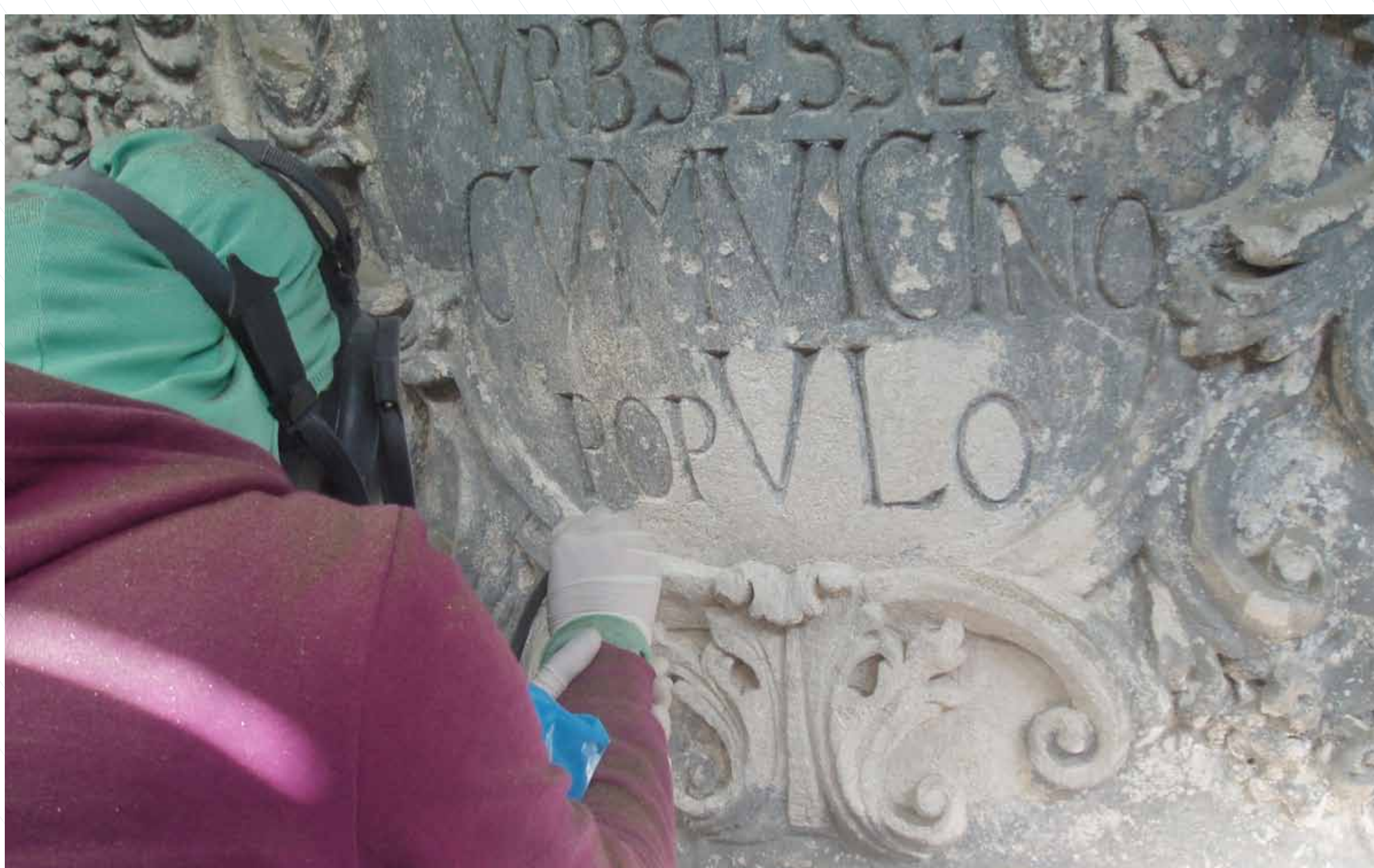
Čišćenje arhitektonskih dijelova mikropjeskarnikom Microsandblasting of architectural parts
