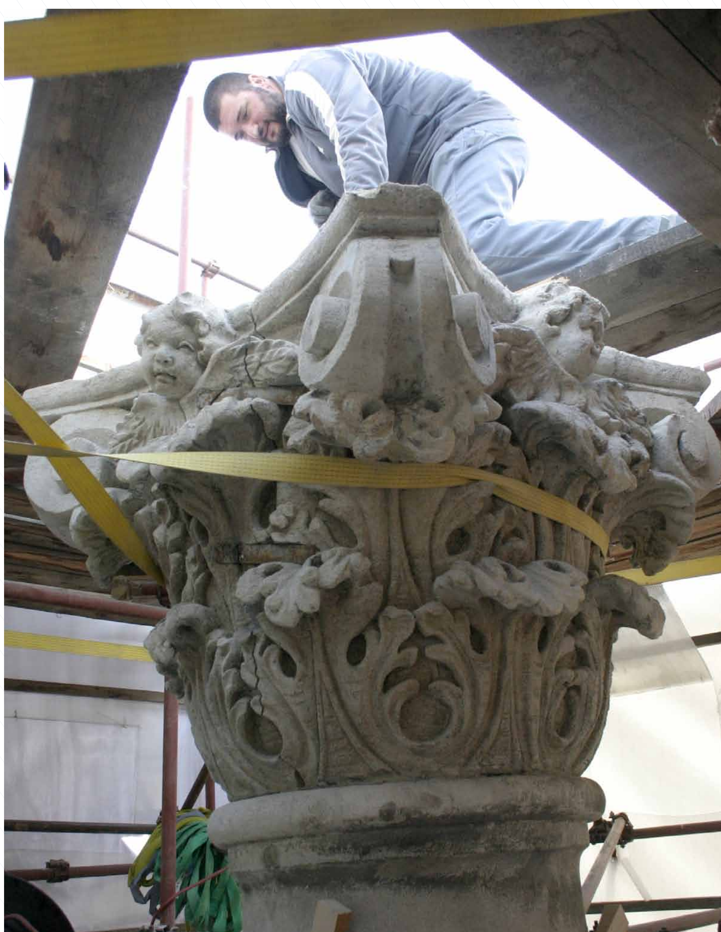
Demontaža kapitela Dismantling of capital
