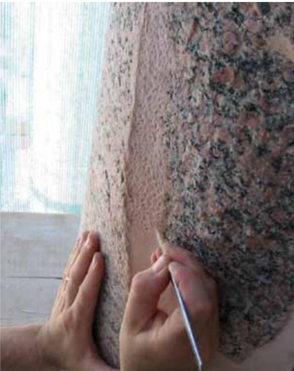
OBRADA I RETUŠ NA REKONSTRUIRANOM DIJELU GRANITNOG STUPA
