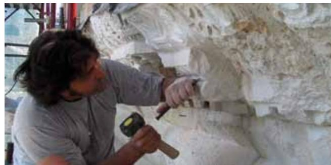
UGRADNJA I OBRADA KAMENOG BLOKA NA VIJENCU ISTOČNE KOLONADE
