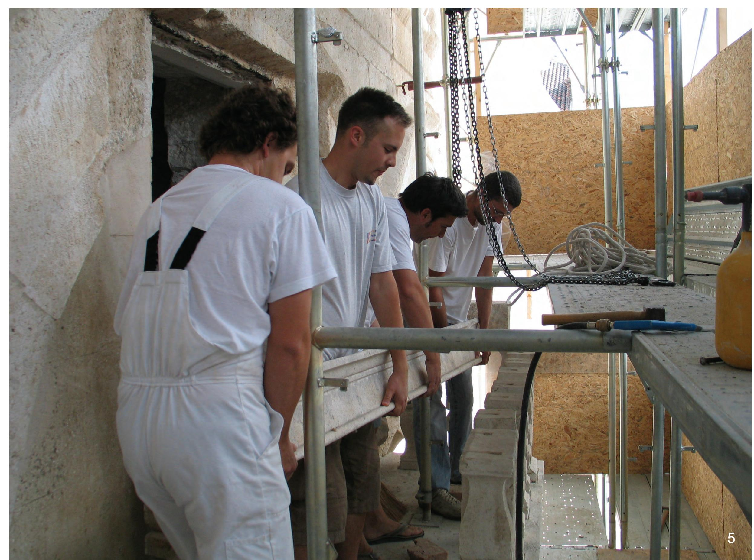
Zbog narušene stabilnosti, većinom zbog djelovanja korozije željeznih kopči i trnova, ograda balkona na drugom katu palače demontirana je i zatim ponovno montirana, što je bio jedan od najsloženijih zahvata ove faze projekta (Sl. 1-3).
