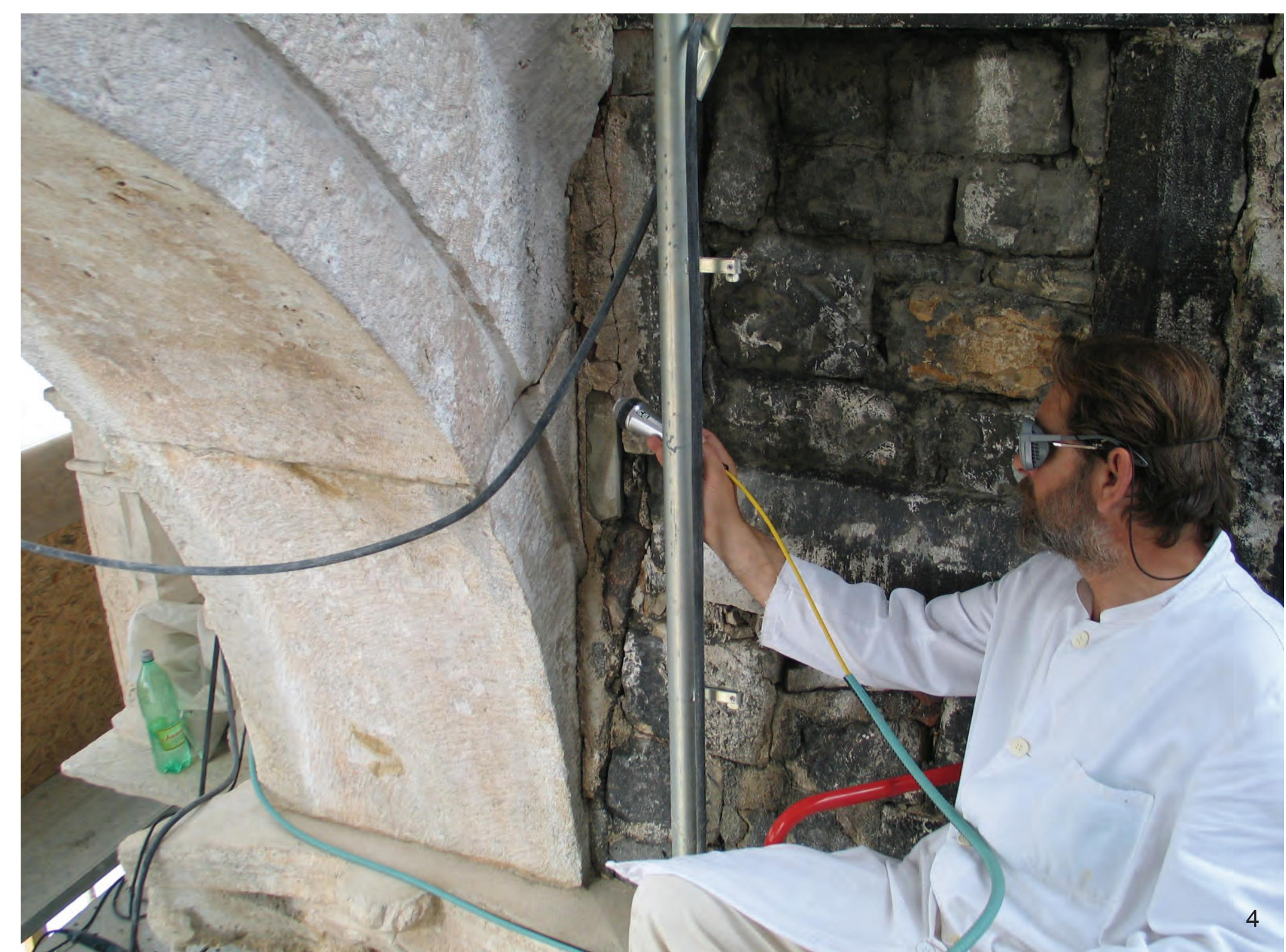
Zbog izloženosti kiši, kamene površine istaknutih dijelova vijenca su erodirane, a fini detalji klesarske obrade potpuno izgubljeni. U sljubnicama između kamenih blokova stanište su pronašle više biljke. Na površinama koje su izložene kiši razvile su se kolonije mikroorganizama, a na onima koje su od kiše zaklonjene formirale su se debele crne kore (SI. 1).
