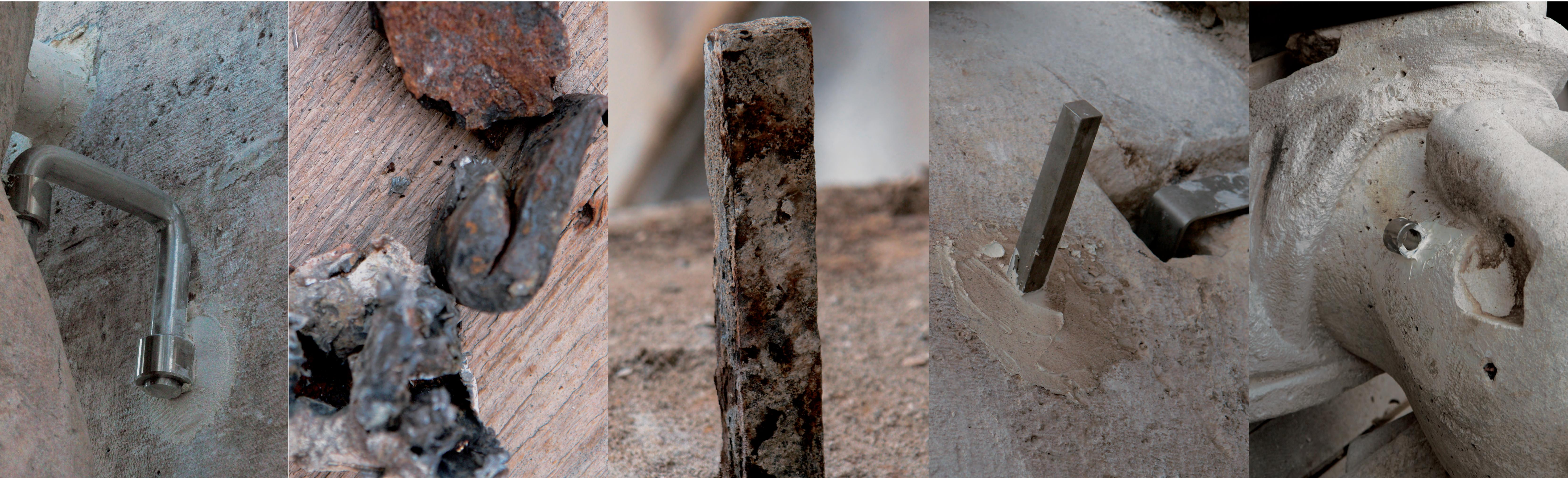
Uklanjanje korodiranih metalnih dijelova iz kamenih elemenata i njihova zamjena dijelovima od nehrđajućeg metala (inoks čelika) izvedeni su tako da su sve korodirane spojnice pažljivo demontirane. Na njihovo mjesto postavljeni su dijelovi od nehrđajućeg čelika koji su po mogućnosti dodatno učvršćeni u kameni materijal dvokomponentnim ljepilom za kamen.
