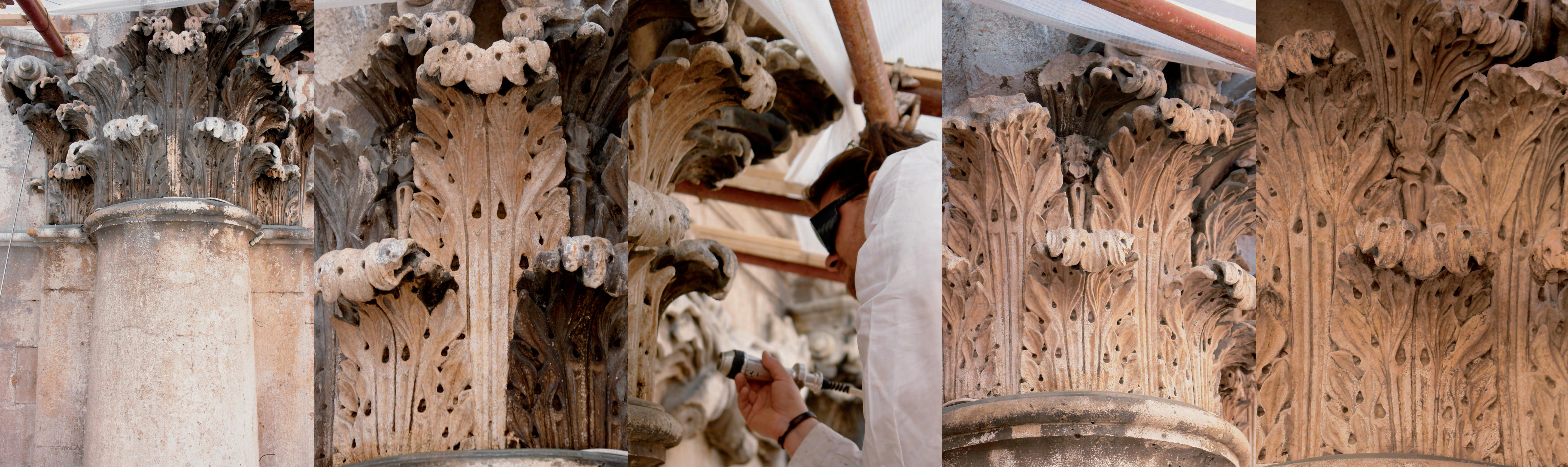
Nakon mehaničkog i kemijskog čišćenja te mikropjeskarenja ustanovljeno je da je nužno izvesti dodatne konzervatorsko-restauratorske radove čišćenja složenijih oblika kamene plastike, i to sofisticiranjem opremom. Metoda čišćenja laserom upotrijebljena je za nečistoće koje se nisu smjele
