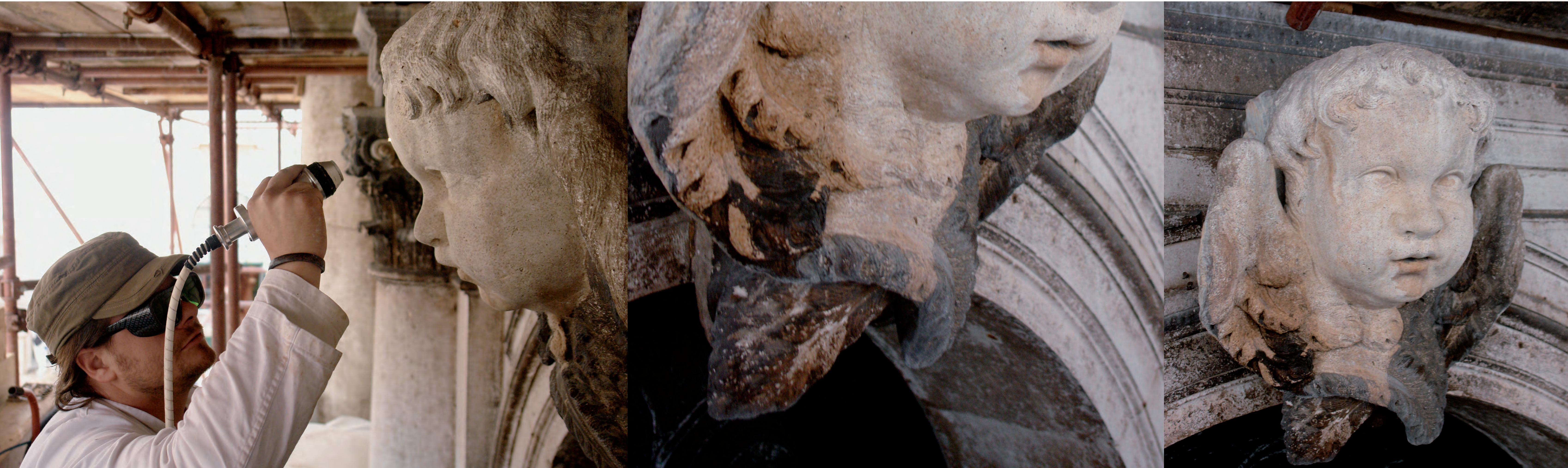
Prije početka čišćenja isključivo laserom napravljeno je nekoliko probnih sondi na zapadnom kapitelu polukružnog pilastra ispod završnog vijenca pročelja. Čišćenje je nakon toga nastavljeno na precizno klesanim vegetabilnim elementima kapitela polukružnih pilastra i pilastra
