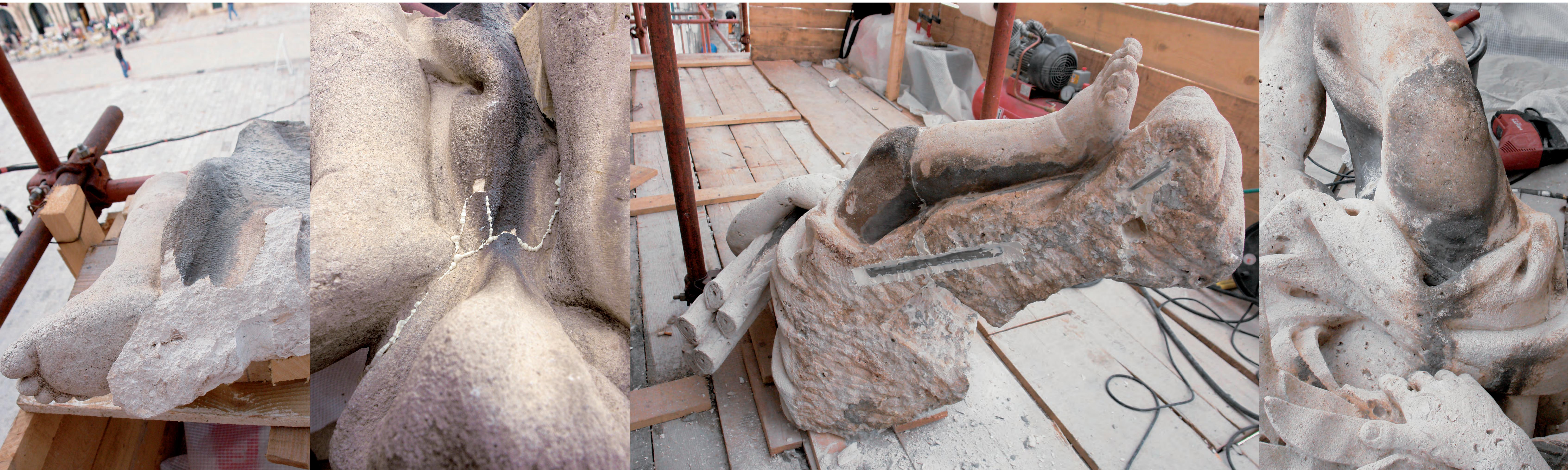
Armatura od nehrđajućeg metala postavljena je tako da se olakša modeliranje formi koje nedostaju i zapunjavanje oštećenja masom umjetnog kamena. Umjetnim kamenom na bazi nekoliko vrsta kamenog brašna, akrilata, gašenog vapna i bijelog cementa domodelirane su forme kamenih arhitektonskih i skulpturalnih elemenata koje
