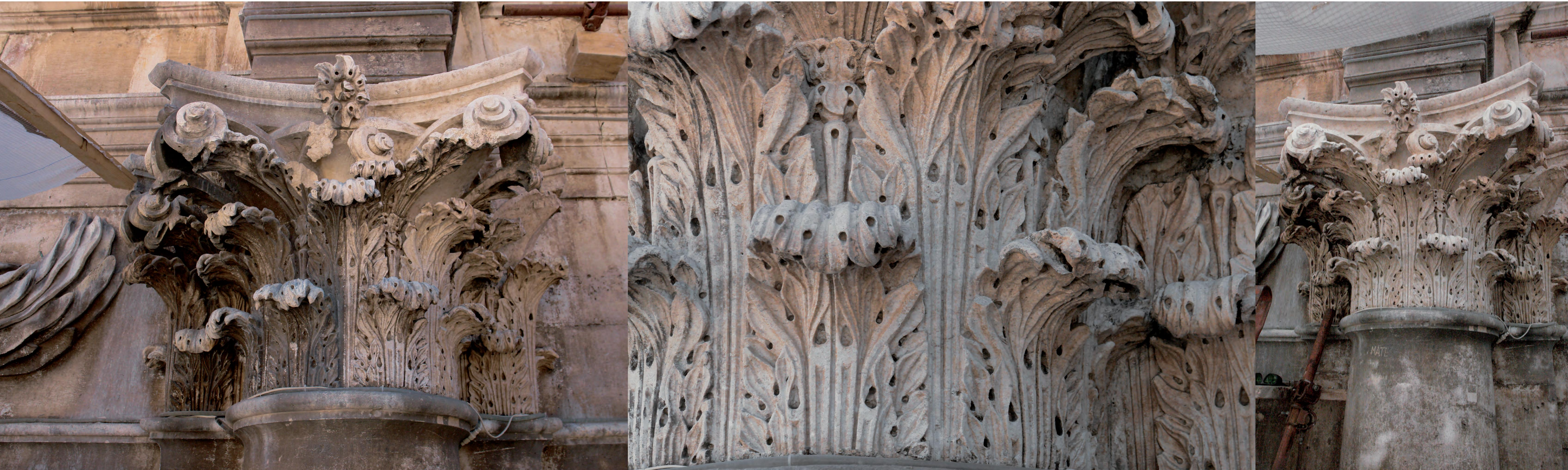
Kada se čisti laserom, prema strukturi kamenog materijala i vrsti nečistoća regulira se omjer udarne točke, snaga i frekvencija te veličina svjetlosnog snopa. Metoda čišćenja laserom učinkovito se koristi
