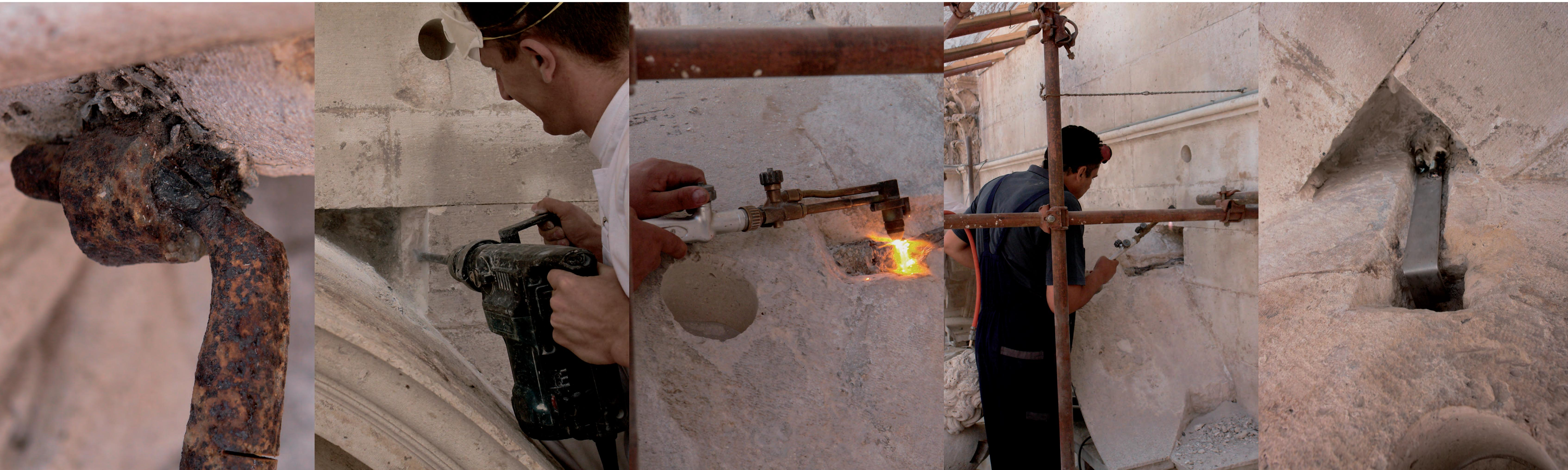
Brojni metalni dijelovi koji su ugrađeni u kamenu strukturu crkve služili su međusobnom povezivanju blokova, povezivanju dekorativnih elemenata i skulptura sa zidnim plaštem ili su bili umetnuti u dijelove kamene plastike iz statickih razloga. Djelovanjem korozije na metalne dijelove došlo je do oštećivanja kamenog materijala, što je pak otvorilo mogućnost daljnje oštećivanja. Oštećenje je najčešće dovelo do bubrenja korodiranih šipki koje su povećavanjem svoga volumena
