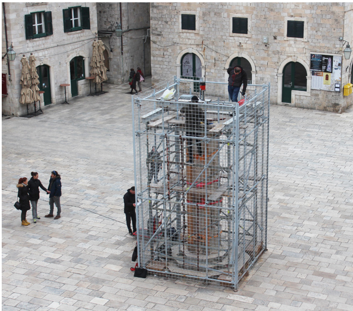
16. Orlando's stup, pokušaj otpuštanja sile na centralnom trnu uz pomoć hidrauličke preše (arhiva GDU, 2024.)
