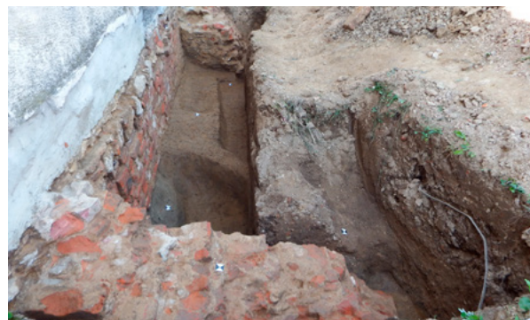
8. Ostatci temelja sjeverne sakristije, pogled s istoka (arhiva HRZ-a, snimka: J. Maslač, Solis arheo, 2023.) Remains of the northern sacristy's foundations, view from the east (HRZ Archive, J. Maslač, Solis arheo, 2023)
