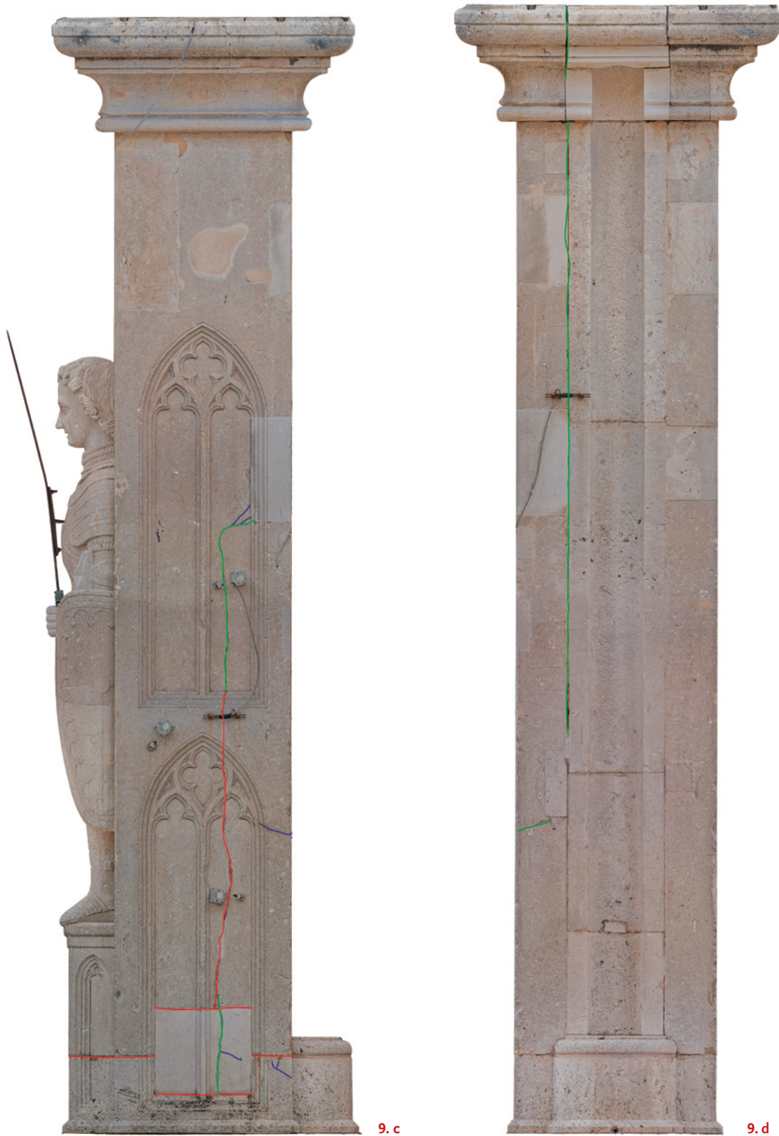
9. Pogledi na razvijeno tijelo Orlandova stupa sa shematskim prikazom pukotina zabilježenih od 2003. do 2018. godine (arhiva HRZ-a, izradila: V. Marinković, 2024.)
