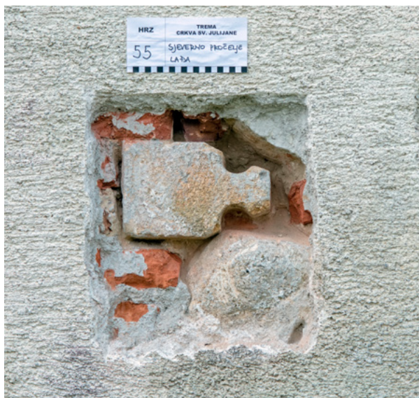
3. Kamena spolija gotičkog rebra uzidana u sjeverno pročelje lađe crkve sv. Julijane (arhiva HRZ-a, snimka: J. Kliska, 2021.) Stone spolia of the Gothic rib built into the north façade of the nave of the church of St. Juliana (HRZ Archive, J. Kliska, 2021)
