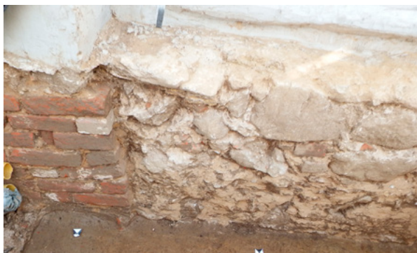
7. Spoj temelja južnog zida lađe i apside (arhiva HRZ-a, snimka: J. Maslač, Solis arheo, 2023.) Seam between the foundations of the southern wall of the nave and the apse (HRZ Archive, J. Maslač, Solis arheo, 2023)
