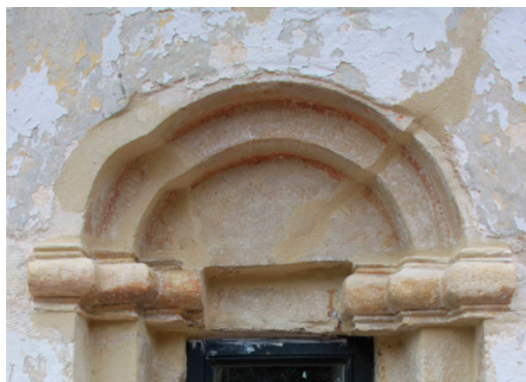
12. Stanje kamenog okvira prozora tambura nakon sanacije (snimka: Z. Vukosavljević, 2021.) Condition of the stone frame of the drum window after renovation (Z. Vukosavljević, 2021)
