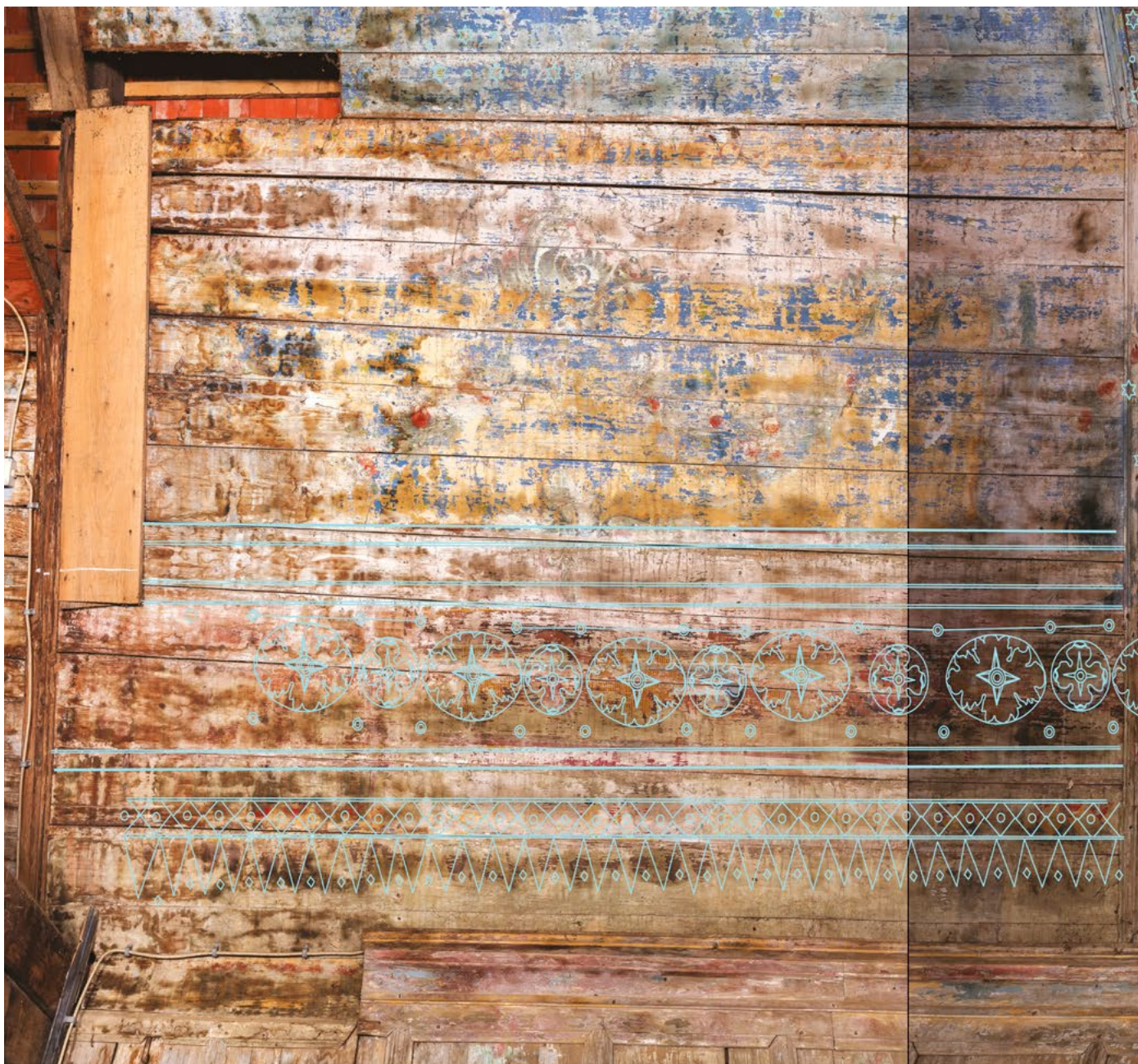
14. Grafička dokumentacija analize druge faze lađe i svetišta, detalj sjevernog zida i svoda (arhiva HRZ-a, izradili T. Kučinac, M. Kamenar, I. Pavičić, 2017.)
