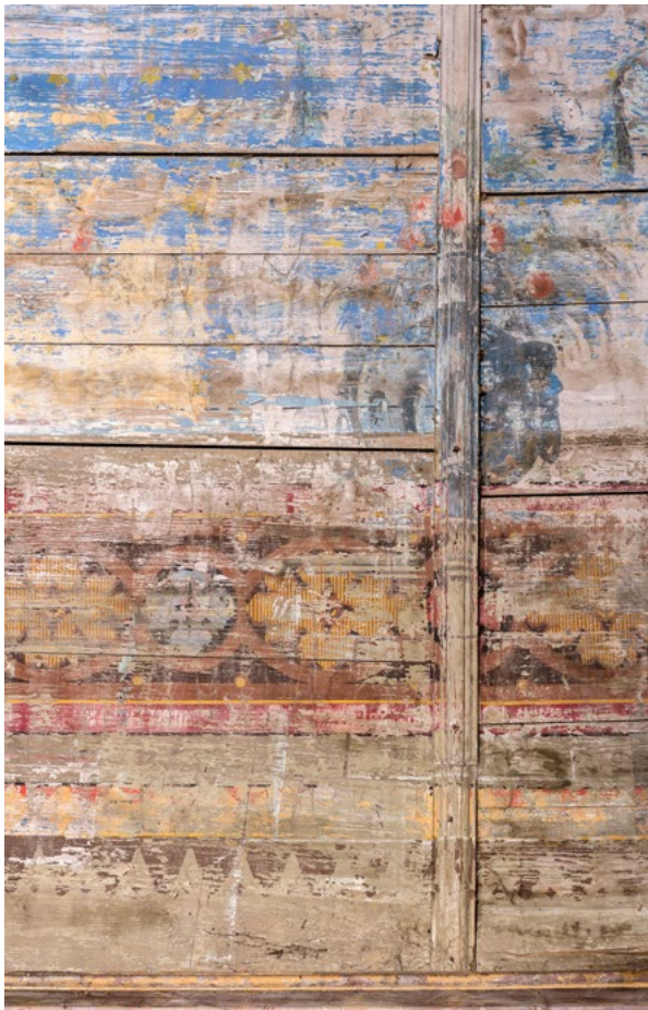
8. Detalj oslikane oplata svoda, vaza s cvijećem i friz s geometrijskim motivima, zatečeno stanje (arhiva HRZ-a, snimka: G. Tomljenović, 2016.) Detail of the painted panelling of the vault, a vase with flowers and a frieze with geometric motifs before conservation (HRZ Photo Archive, G. Tomljenović, 2016)
