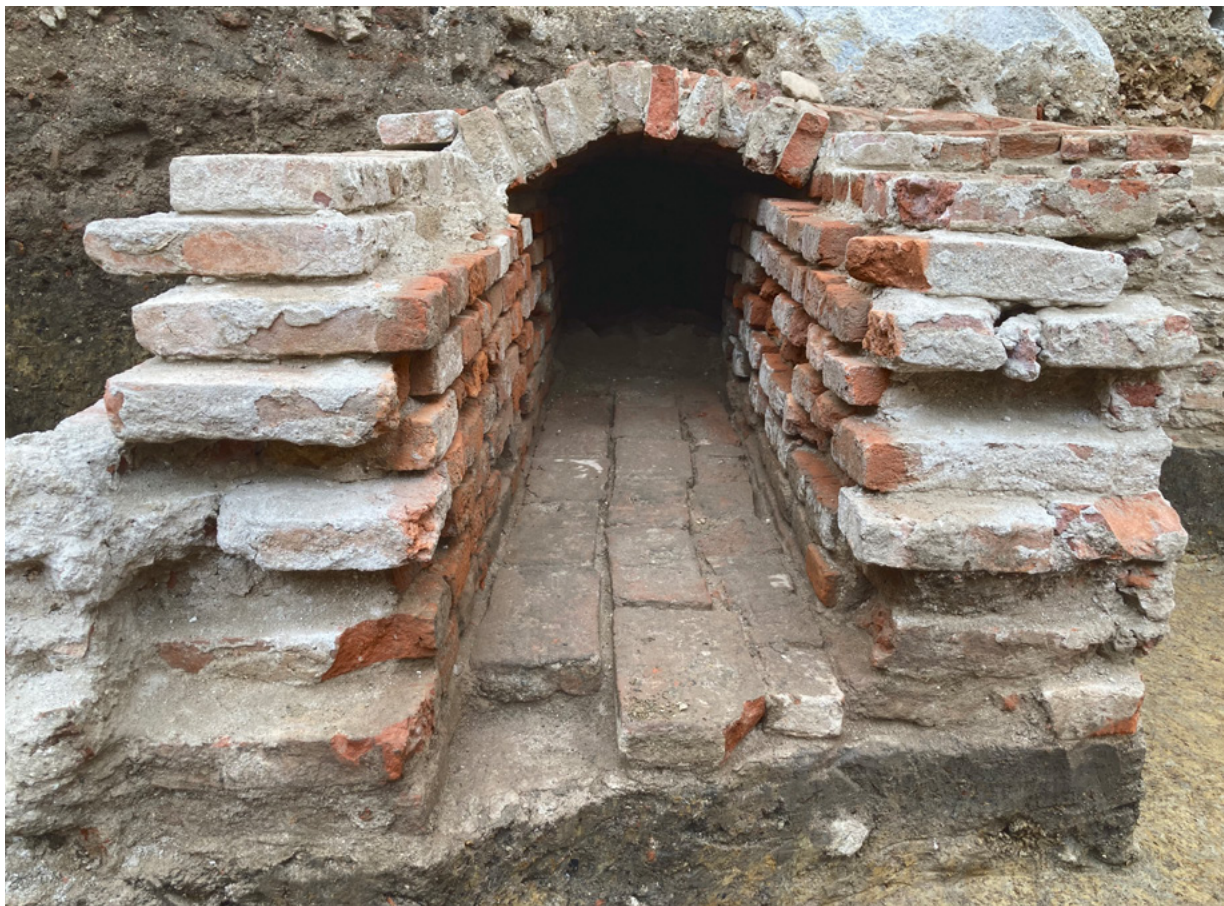
7. Ostaci starije faze kanalizacijskog sustava (Sj 12) pronađenih tijekom arheoloških istraživanja 2021. godine (snimka: P. Sekulić, 2021.) Remains of the older phase of the sewerage system (Sj 12) found during archaeological research in 2021 (P. Sekulić, 2021)
