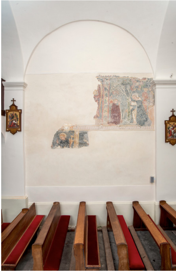
17. Sjeverni zid lađe nakon konzervatorsko-restauratorskih radova (fototeka HRZ-a, snimio J. Kliska, 2018.) North wall of the nave after conservation (Croatian Conservation Institute Photo Archive; J. Kliska, 2018)
