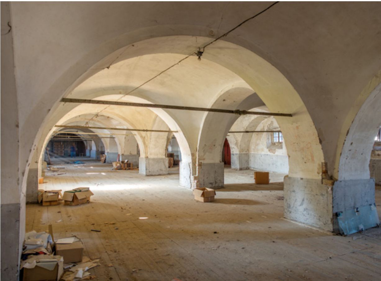
Sl. 10. Unutrašnjost skladišnog prostora drugog kata (fototeka HRZ-a, snimio G. Tomljenović) Interior of the storage area on the 2 nd floor (Croatian Conservation Institute Photo Archives, G. Tomljenović)
