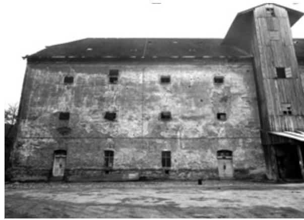
Sl. 7. Drvena oplata teretnog dizala (Državni arhiv u Osijeku, 1972./1973.) Cargo elevator wooden panelling (State Archives in Osijek, 1972/1973)
