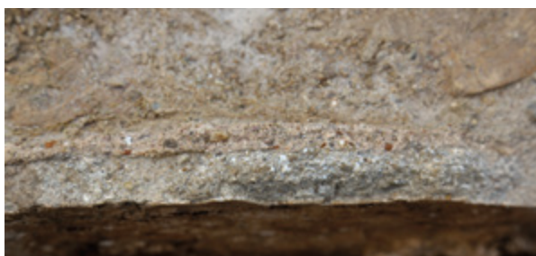
7. Presjek žbuknog sloja (snimila A. Požar Piplica) Plaster layer cross-section (A. Požar Piplica)
