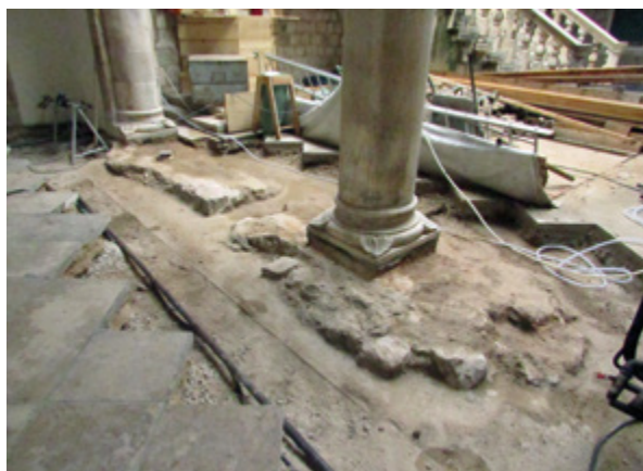
7. Pogled na zapadne stupove i temelje u atriju Dvora, JZ-SI (Dokumentacija o arheološkom nadzoru, Zavod za obnovu Dubrovnika, snimila N. Topić, 2016.)
