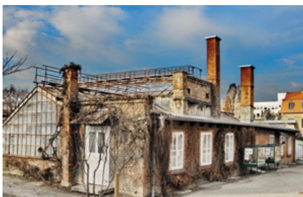
10. Staklenici sa sjeveroistoka 2012. (snimio M. Perušić) Greenhouses view from the north-east, 2012 (M. Perušić)
