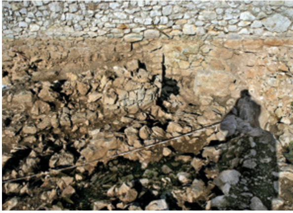
7 Ostaci izvornog ulaza Tvrđave Barone s unutarnje strane (snimio I. Glavaš, 2015.)
