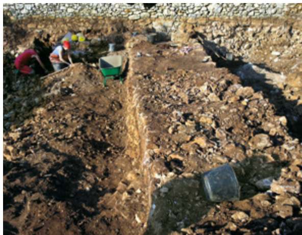
4 Ostatak obrambenog bedema i sjeverozapadna kurtina (snimio I. Glavaš, 2014.) Remains of fortifications and northwest curtain wall (I. Glavaš, 2014)
