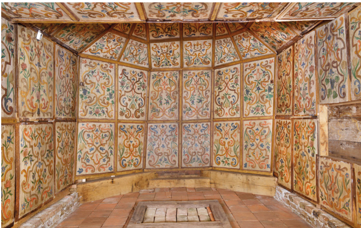
14. Pogled na svetište nakon montaže restaurirane oslikane drvene oplate (fototeka HRZ-a, snimila N. Oštarijaš, 2015.)
