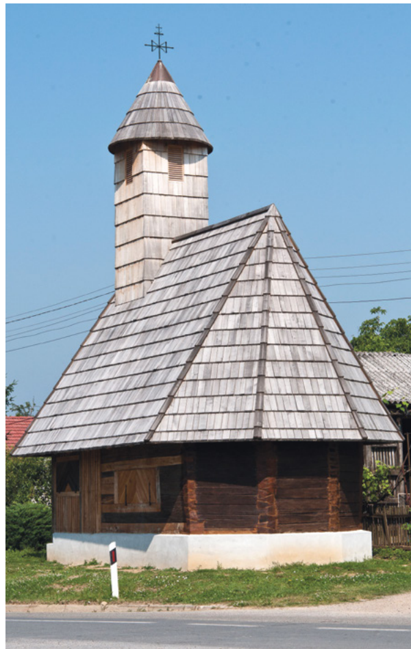
8. Kapela nakon građevinskih radova (fototeka HRZ-a, snimio Lj. Gamulin, 2013.)
