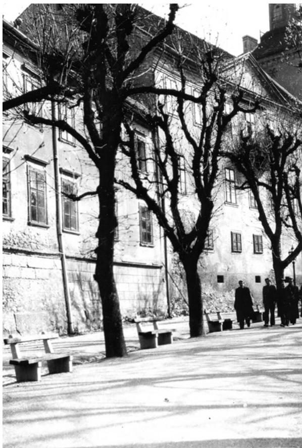
10. Pročelje sklopa „kuća Hellenbach“ sa Strossmayerova šetališta, 1940.; drugi kat nadograđen je 1836., a balkon i zabat izvedeni su 1862. (fototeka MGZ-a, 13477)
