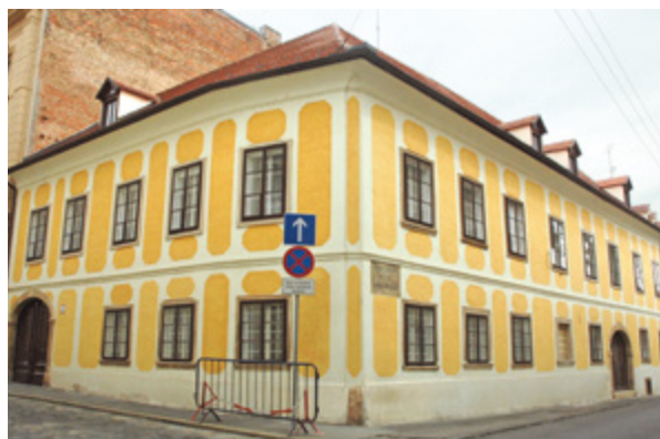
20. Zagreb, kuća Igerčić u Freudenreichovoj 3, pročelja (snimio P. Puhmajer, 2014.) Zagreb, Igerčić House on 3 Freudenreichova Street (photo by P. Puhmajer, 2014)
