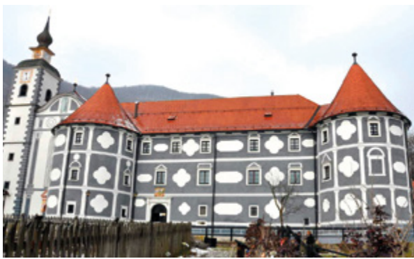
15. Olimje, bivši pavlinski samostan, vanjska pročelja samostana (izvor: http://kraji.eu/slovenija/minoritski_samostan_grad_olimje/slo , preuzeto: 7. lipnja 2015.) Olimje, Pauline Monastery, outer façades ( http://kraji.eu/slovenija/minoritski_samostan_grad_olimje/slo , accessed: June 7, 2015)
