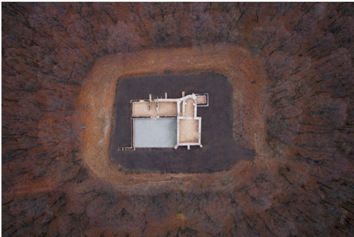
Slika 1. Pogled iz zraka nakon dovršetka radova
