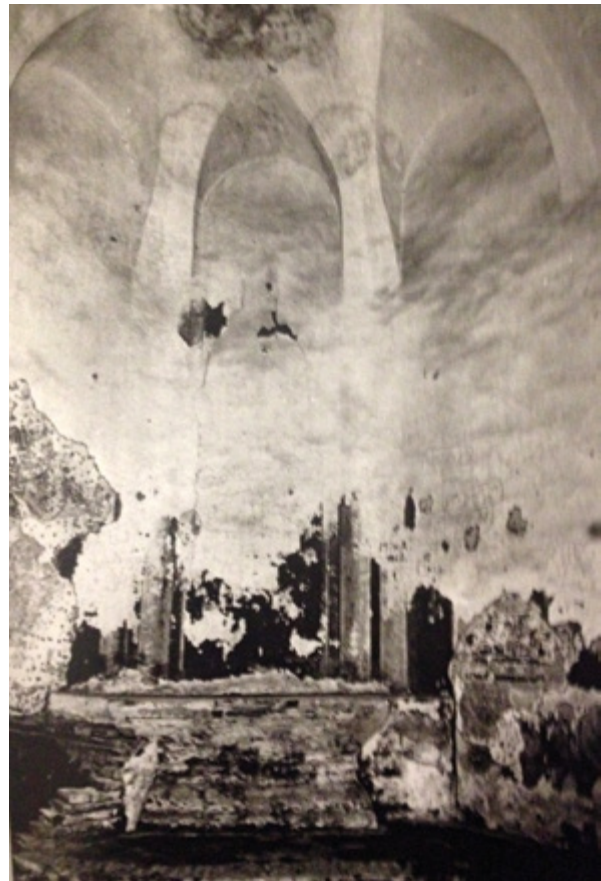
9. Pogled na zaključak kapele sv. Jelene u Šenkovcu prije radova (preuzeto od IVANA SRŠE 1991., crno-bijela fotografija br. 1) View of the Šenkovec chapel of St. Helen end, before conservation (taken from IVAN SRŠA 1991, black-and-white photo no. 1)
