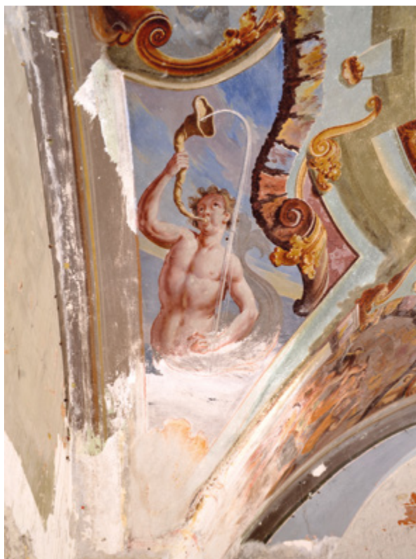
10. Zatečeno stanje freske na jugozapadnoj peti svoda prije početka istraživanja. Vidljiva je pulverizacija i isipanje slikanog sloja (fototeka HRZ-a, snimio J. Kliska, 2013.)
