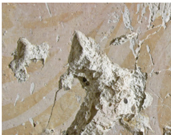
7. Oštećenja žbukanih i slikanih slojeva uzrokovana čekićem (snimio B. Hacker, 2009.) Damages of the plaster and paint layers inflicted with a hammer (photo by B. Hacker, 2009)
