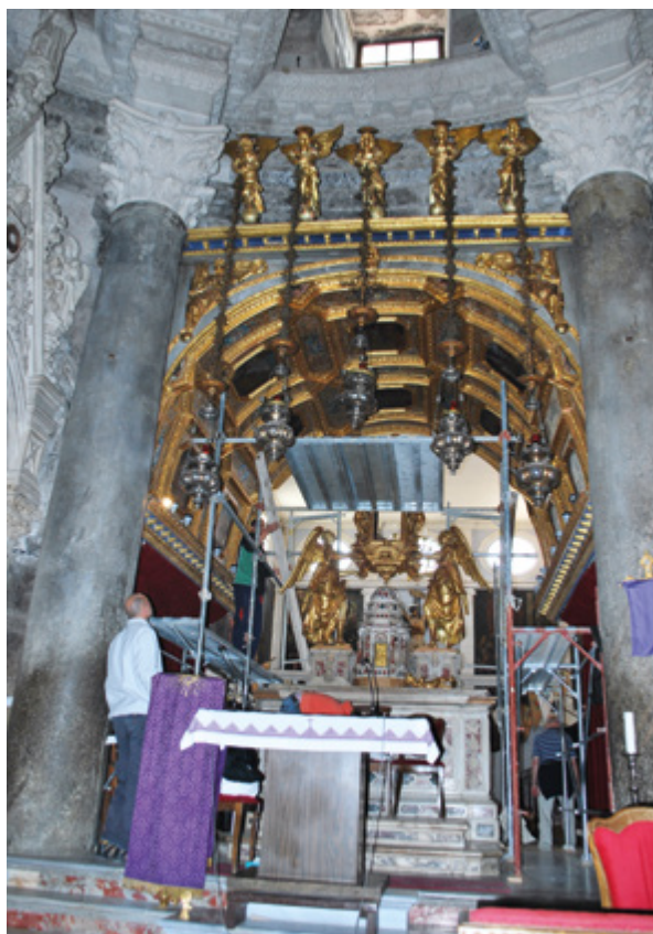
26. Rad na skeli tijekom restauracije svoda (snimila K. Svedružić, 2007.)
