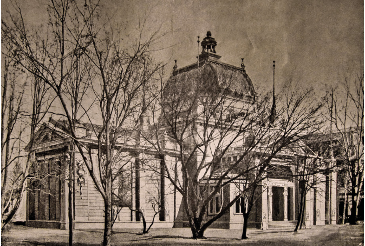
8. Paviljon za Poviest i umjetnost s jugozapada 1896., (dokumentacija M. Perušić) History and Art Pavilion from the southwest, 1896 (Documentation M. Perušić)
