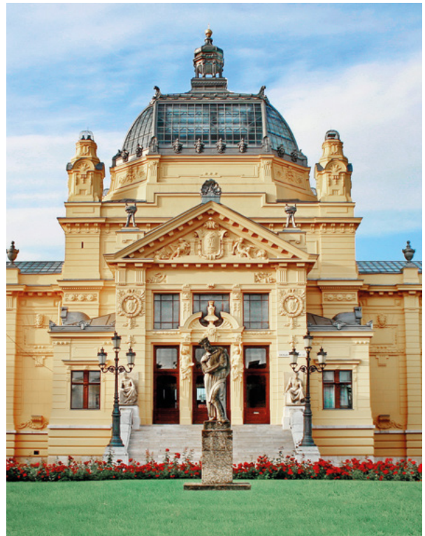
28. Srednji dio sjevernog pročelja, 2013. (snimio D. Fabijanić) Central portion of the north front, 2013 (photo by D. Fabijanić)
