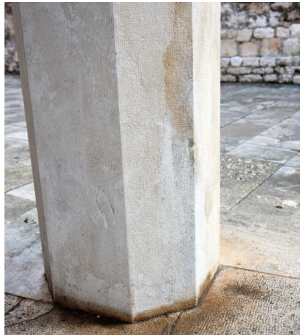
5. Cvjetanje, iscvjetavanje, ili eflorescencija? Ulaz u kuću Male lođe u Šibeniku (snimila K. Hraste, 2014.) Blooming, flowering, or efflorescence? Entrance to the house of the Small Loggia in Šibenik (photo by K. Hraste, 2014)
