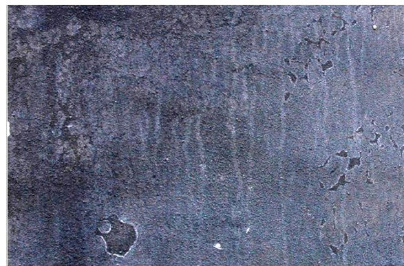
19. Detalj industrijske boje na istočnom pročelju Palaisa, Veliki Tabor, stanje 2011. godine. (fototeka HRZ-a, snimio I. Srša)
