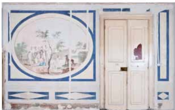
Drugi kat upravne zgrade bivše rafinerije šećera, prostorija 22, pogled na istočni zid (nakon čišćenja)
