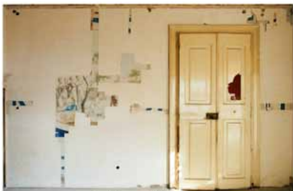
Drugi kat upravne zgrade bivše rafinerije šećera, prostorija 22, pogled na istočni zid (prije čišćenja)
