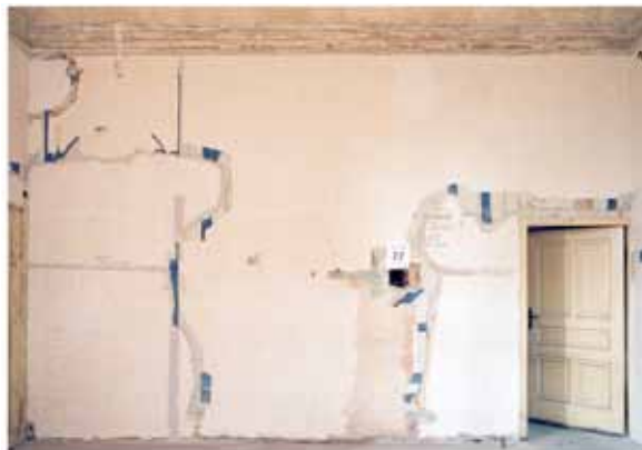
Drugi kat upravne zgrade bivše rafinerije šećera, prostorija 22, pogled na sjeverni zid (prije čišćenja)
