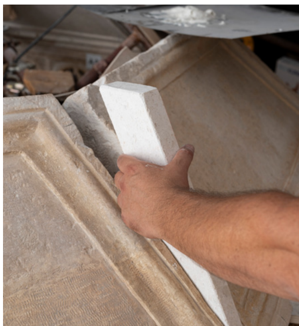
18. Korčula, katedrala sv. Marka, umetanje kamenih kajli između elemenata B (fototeka HRZ-a, snimio P. Gamulin, 2019.) Korčula, Cathedral of St. Mark, insertion of stone begs between B elements (HRZ Photo Archive; P. Gamulin, 2019)
