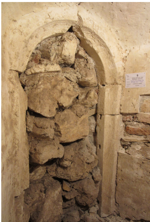
8. Brdovec, župna crkva sv. Vida, prozor na južnom zidu lađe (snimio V. Varšić, 2016.) Brdovec, parish church of St. Vitus, window on the south wall of the nave (V. Varšić, 2016)
