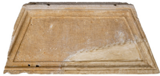
8. Znatno oštećene profilacije na elementu B5 (fototeka HRZ-a, snimio J. Kliska, 2019.) Significantly damaged mouldings on element B5 (HRZ Photo Archive; J. Kliska, 2019)
