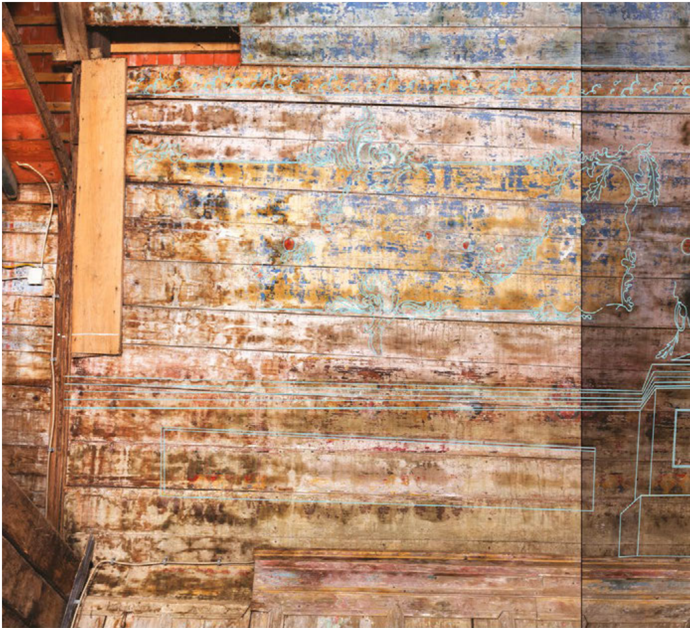
11. Grafička dokumentacija analize prve faze lađe i svetišta, detalj sjevernog zida i svoda (arhiva HRZ-a, izradili T. Kučinac, M. Kamenar, I. Pavičić, 2017.)
