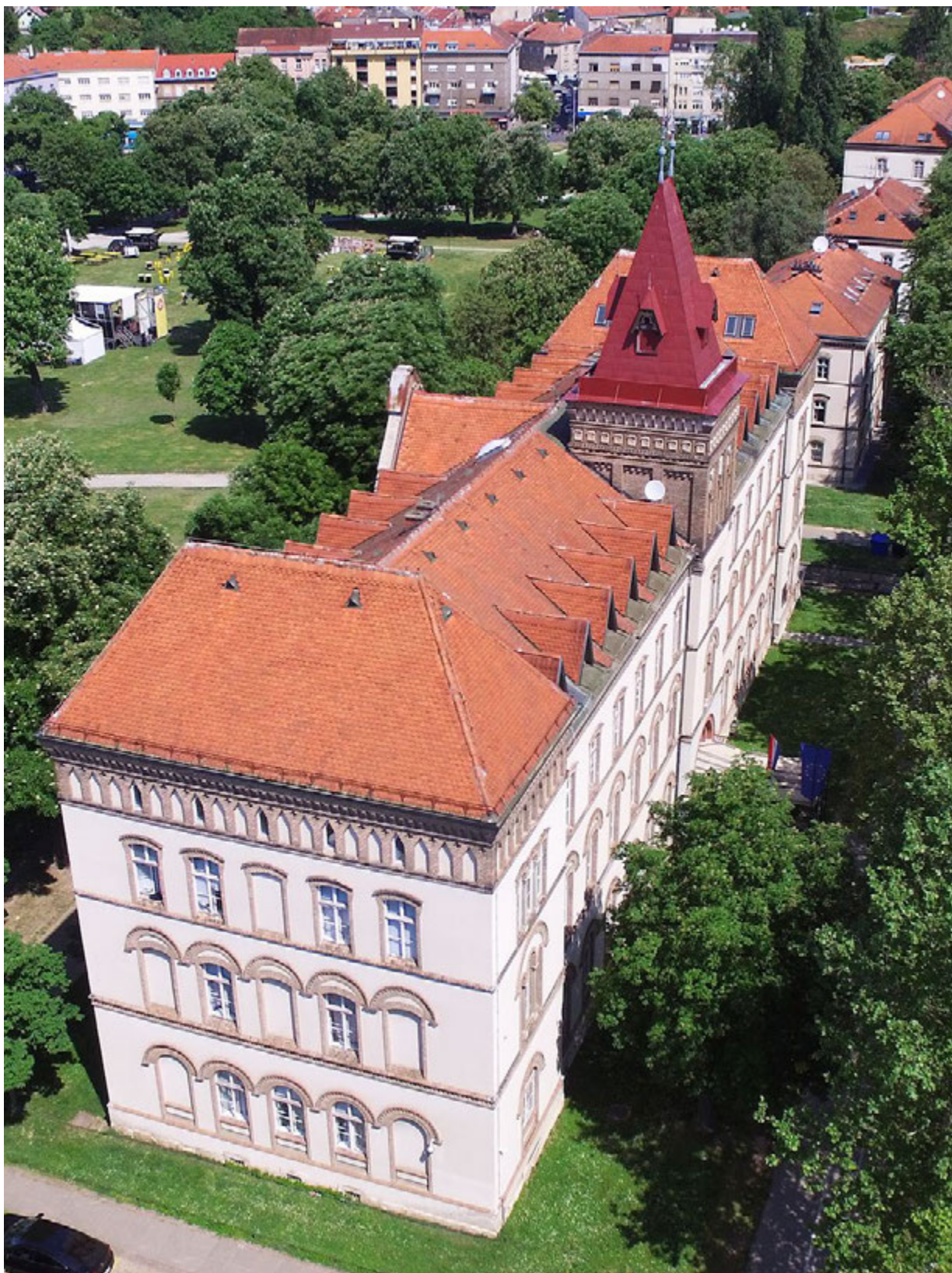
15. Ministarstvo prostornog uređenja, graditeljstva i državne imovine, pogled iz zraka s jugoistoka (snimila tvrtka Mplan d.o.o., 2022.) Ministry of Physical Planning, Construction and State Assets, aerial view from the southeast (Mplan d.o.o., 2022)
