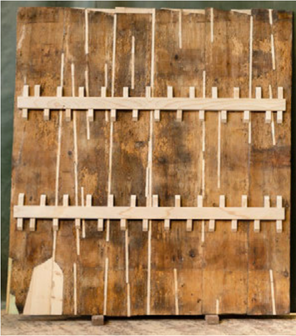
12. Središnja kasetna nakon stolarske sanacije (arhiva HRZ-a, snimka: N. Oštarijaš, 2019.) Central cassette after carpentry restoration (HRZ Archive, N. Oštarijaš, 2019)
