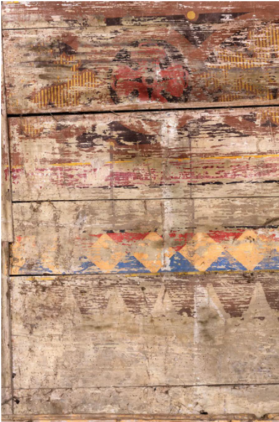
12. Detalj oslikane oplate svoda, detalj friza sa geometrijskim motivima, zatečeno stanje (arhiva HRZ-a, snimka: G. Tomljenović, 2016.) Detail of the painted panelling of the vault, detail of the frieze with geometric motifs before conservation (HRZ Photo Archive, G. Tomljenović, 2016)
