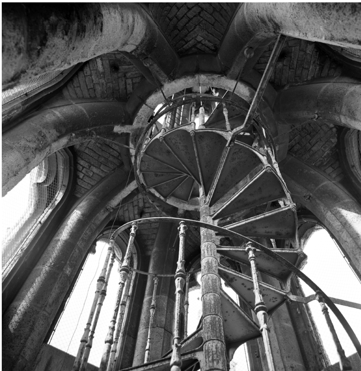
5. Željezno stubište u tornju zvonika primjer je devetnaestostoljetnog jedinstva umjetnosti i tehnike. (Fototeka IPU-a, NG-12447, snimka: N. Gattin)
