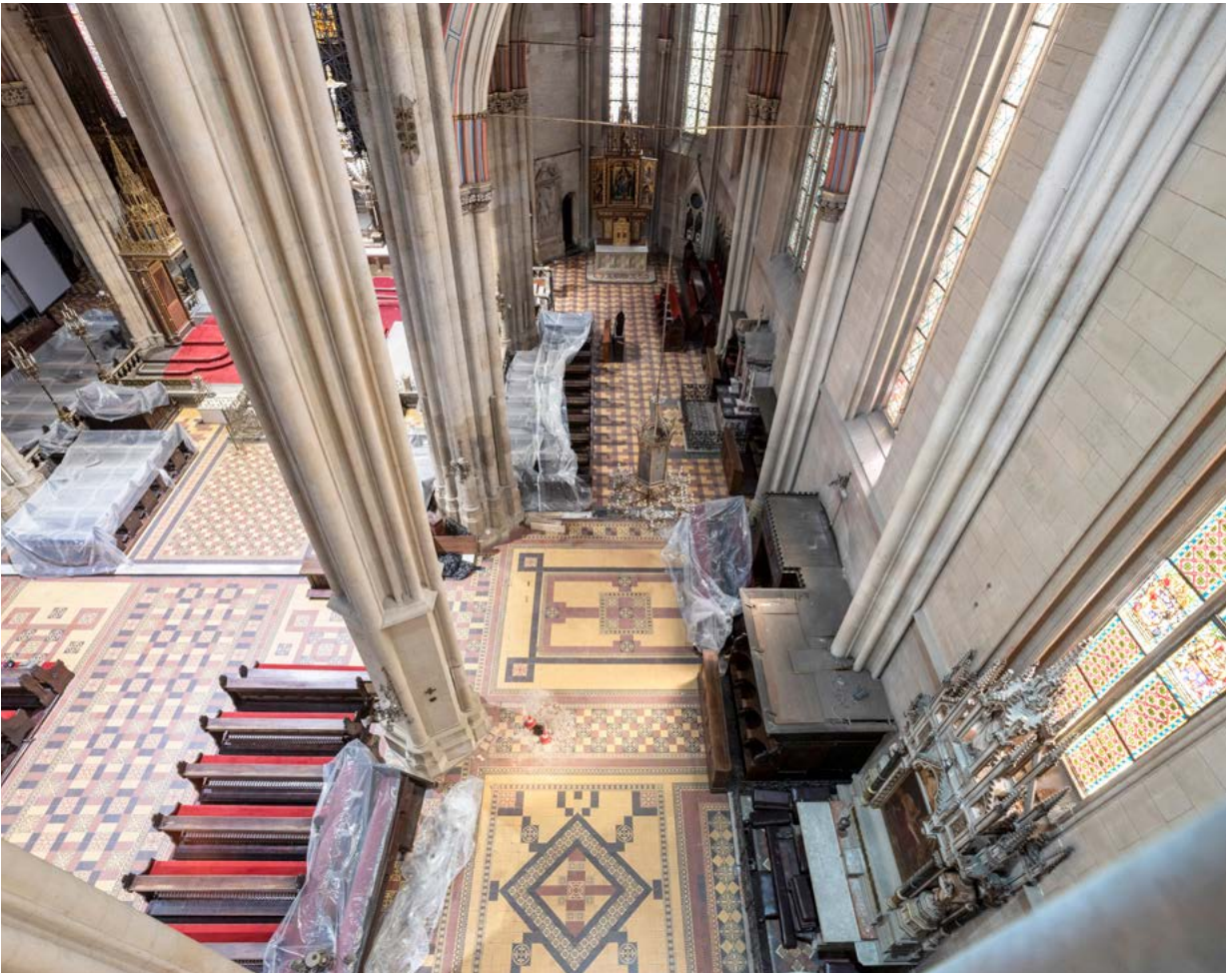
17. Pogled na dio poda južnog i srednjeg broda (arhiva HRZ-a, snimka: Lj. Gamulin, K. Gavrilica, 2022.) View of part of the floor of the southern aisle and central nave (HRZ Archive, Lj. Gamulin, K. Gavrilica, 2022)
