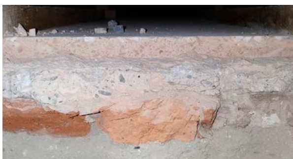
15. Stratigrafija teraco poda u svetištu (arhiva HRZ-a, snimka: T. Šaina, 2022.)
