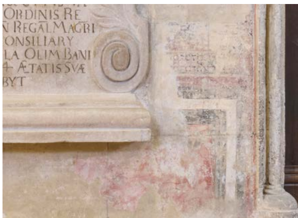
5. Detalj zidne slike s marmorizacijom na sjevernom zidu zaključka južne lađe (arhiva HRZ-a, snimka: K. Gavrilica, 2023.) Detail of a wall painting with marbling on the north wall of the end of the south nave (HRZ Archive, K. Gavrilica, 2023)
