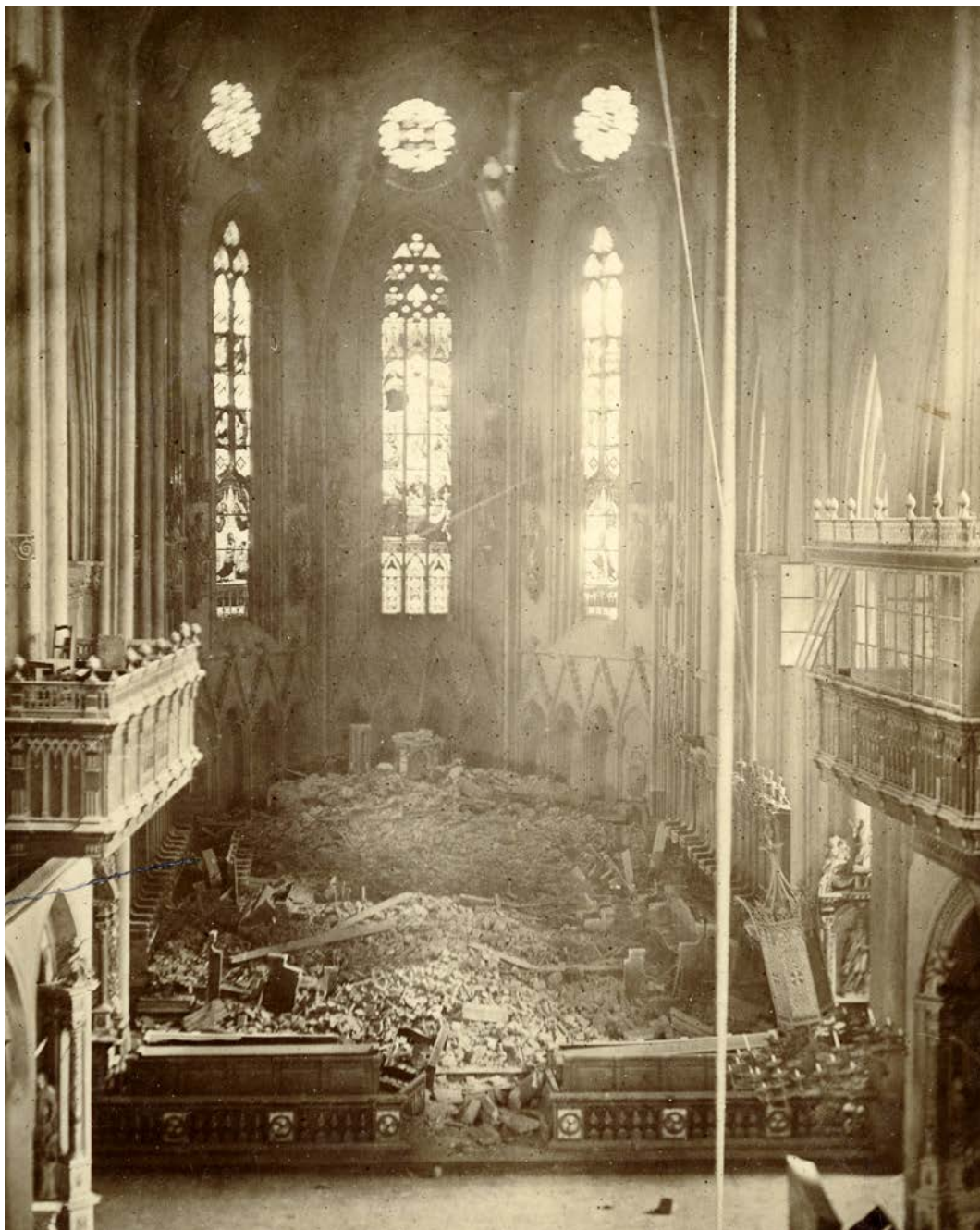
13. Svetište zagrebačke katedrale sa srušenim svodom Hansa Alberthala u potresu 1880. godine (MGZ, Zbirka fotografija zagrebačkih događanja, inv. br. fot-12678, snimka: O. Dasch, 9. studenoga 1880.) Sanctuary of the Zagreb cathedral with the collapsed vault by Hans Alberthal in the 1880 earthquake (MGZ, Collection of Photographs of Zagreb events, inv. no. fot-12678, O. Dasch, 9 November 1880)
