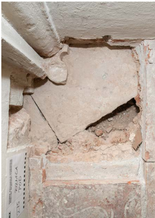
20a. Sonda 275, otkrivene podne strukture i izvorno kameno popločenje s dijelom starog svodnog rebra bademaste profilacije, jugoistočni kut zapadne prostorije riznice (arhiva HRZ-a, sondirao: M. Jelenčić, snimka: K. Gavrilica, 2022.) Probe 275, newly-discovered floor structures and original stone paving with part of the old arch rib with almond-shaped moulding, southeast corner of the western treasury room (HRZ Archive; probe: M. Jelenčić; photo: K. Gavrilica, 2022)
