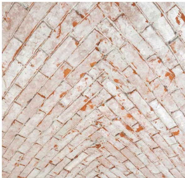
13b. Opečna građa svoda s kraja 19. stoljeća, tijekom radova građevinske sanacije (arhiva HRZ-a, snimka: K. Gavrilica, 2024.) Brickwork of the vault from the end of the 19 th century during reconstruction (HRZ Archive, K. Gavrilica, 2024)
