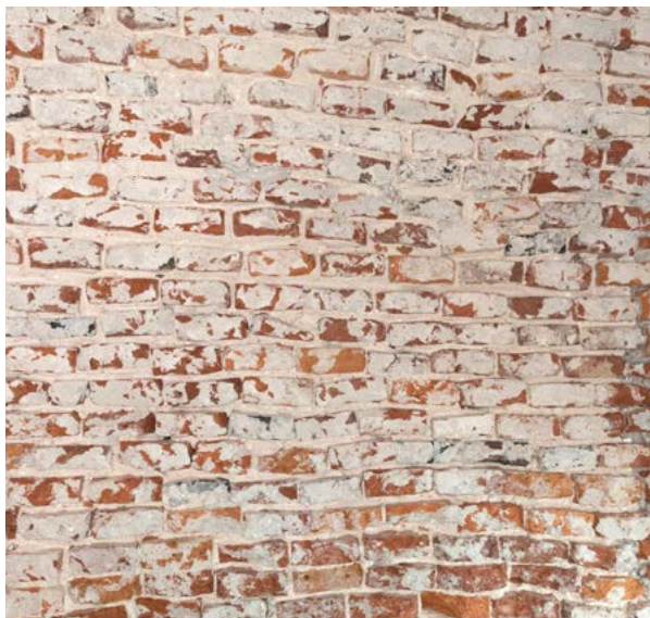
13a. Opečna građa starog svoda, tijekom radova građevinske sanacije (arhiva HRZ-a, snimka: K. Gavrilica, 2024.) Brickwork of the old vault of the cathedral during reconstruction (HRZ Archive, K. Gavrilica, 2024)
