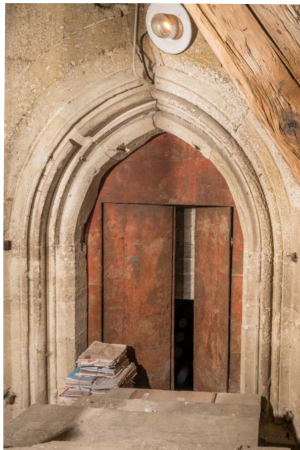
19. Srednjovjekovni prozor na istočnom zidu istočne prostorije riznice, danas ulaz u potkrovlje nad novom sakristijom (arhiva HRZ-a, snimka: K. Gavrilica, 2022.) Medieval window in the east wall of the eastern treasury room, today the entrance to the attic above the new sacristy (HRZ Archive, K. Gavrilica, 2022)
