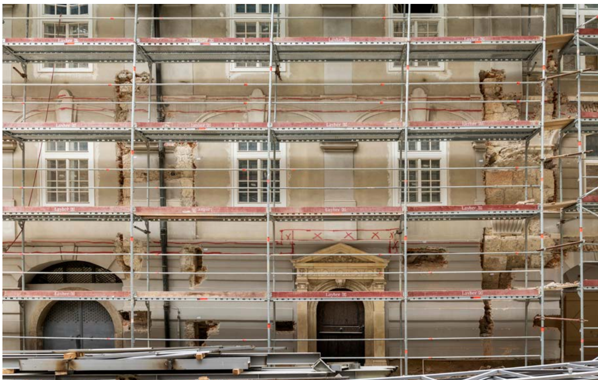
12. Sjeverno pročelje južnog krila Nadbiskupskog dvora, sondirani položaji uzdužnih zidova nekadašnjega spojnog mosta između dvora i katedrale (arhiva HRZ-a, snimka: K. Gavrilica, 2023.)
