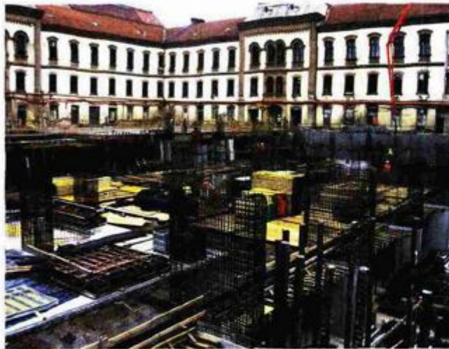
Izgradnja podzemnog dijela građevine
