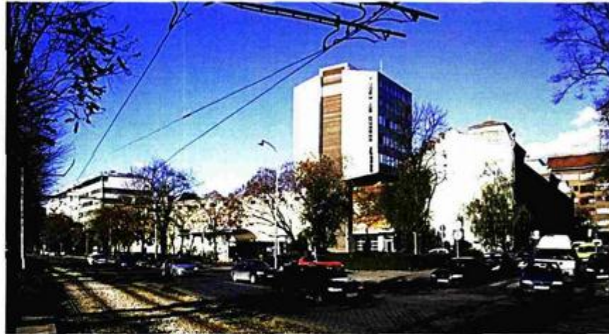
Južna dogradnja Tvornice duhana iz 1971 (prije rušenja)
