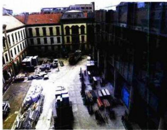
Pogled sa zapadne prigradnje na unutrašnji trg tijekom posjeta
