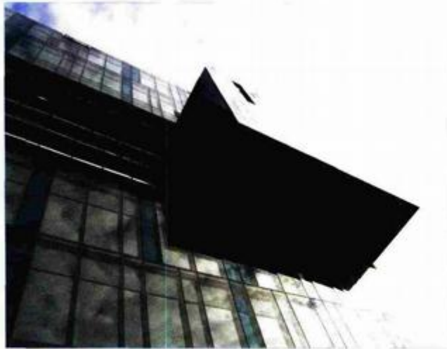
Detalj staklenoga pročelja snimljen tijekom posjeta
