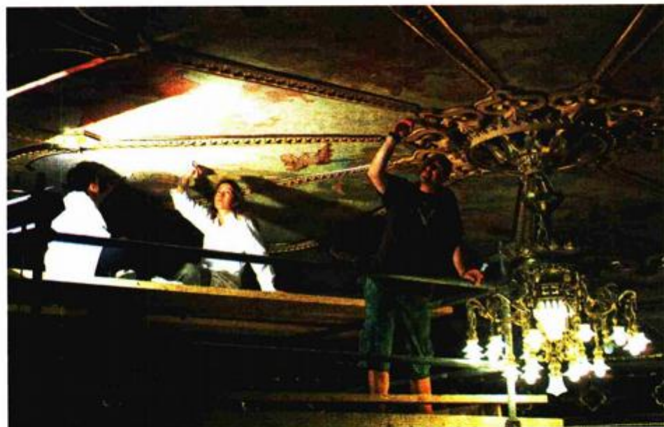
Zbog nemogućnosti odvajanja slike od stropa, ekipa dubrovačkih restauratora zahvat su morali obavljati 'in situ'
